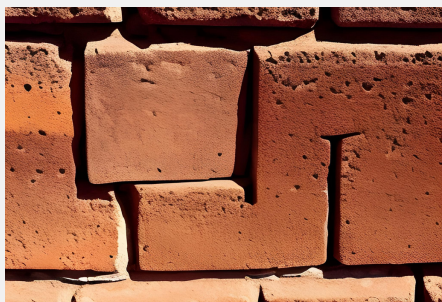
Figura 6: Bloco de adobe.
