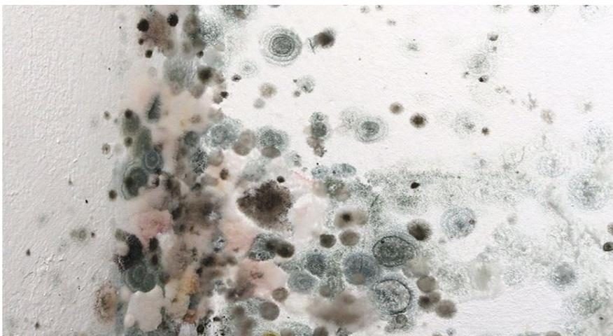
Figura 2 – parede com mofo e bolor
