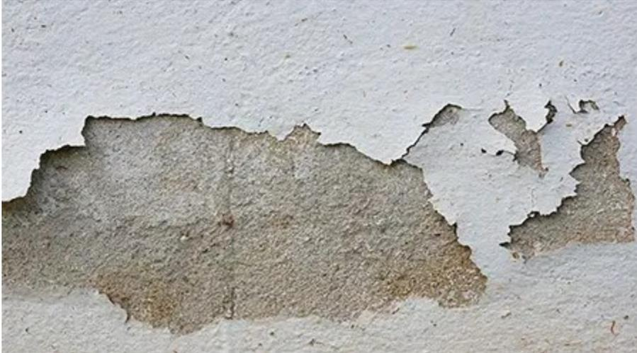
Figura 5 – Pintura descolando devido à umidade
