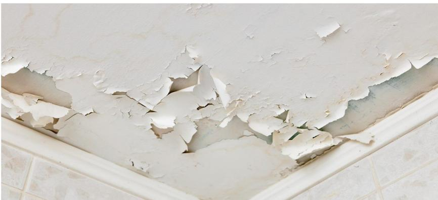
Figura 4 – descascamento na laje devido à umidade
