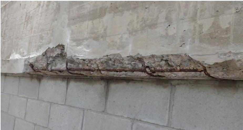
Figura 3 – estrutura com armadura aparente devido à umidade
