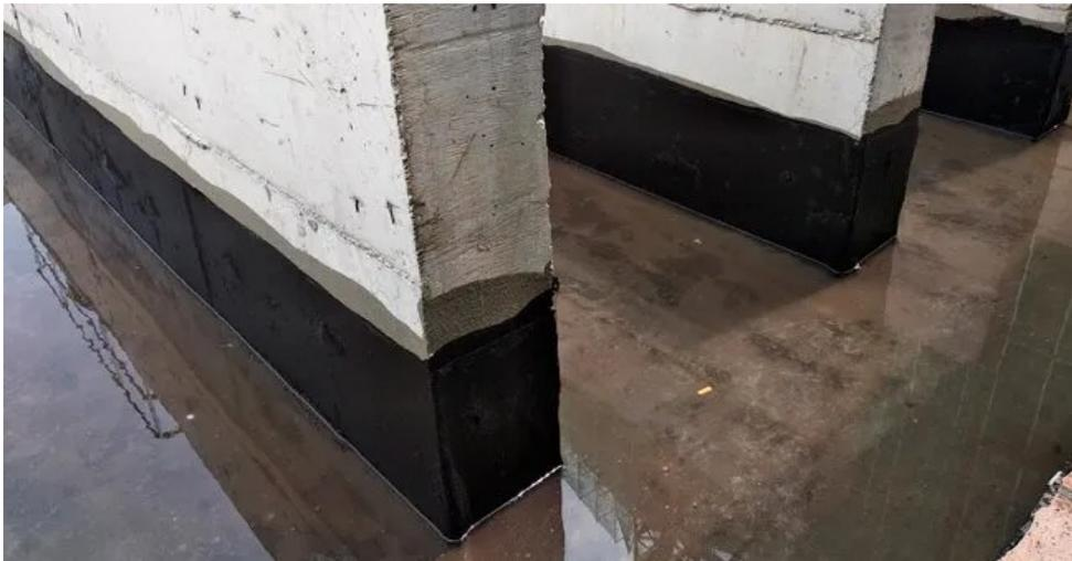
Figura 9- exemplo da realização de um teste de estanqueidade
