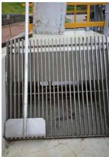
**Figura 13: MATERIAL UTILIZADO NO SISTEMA DE GRADEAMENTO**
