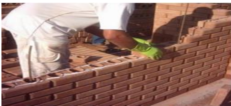
Figura 8- Processo de colagem dos tijolos solo-cimento Fonte: Carvalho, 2014
