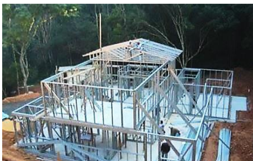
Figura 6: Sistema construtivo Light Steel Framing . Fonte: Valim (2014).
