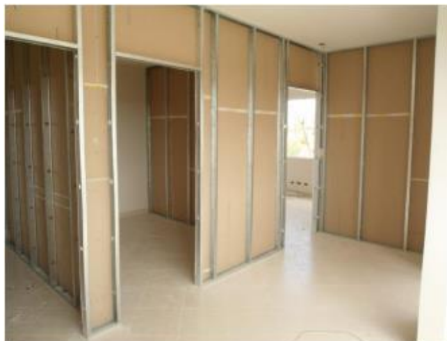
Figura 5: Instalação de chapas de gesso acartonado. Fonte: Duarte (2014)
