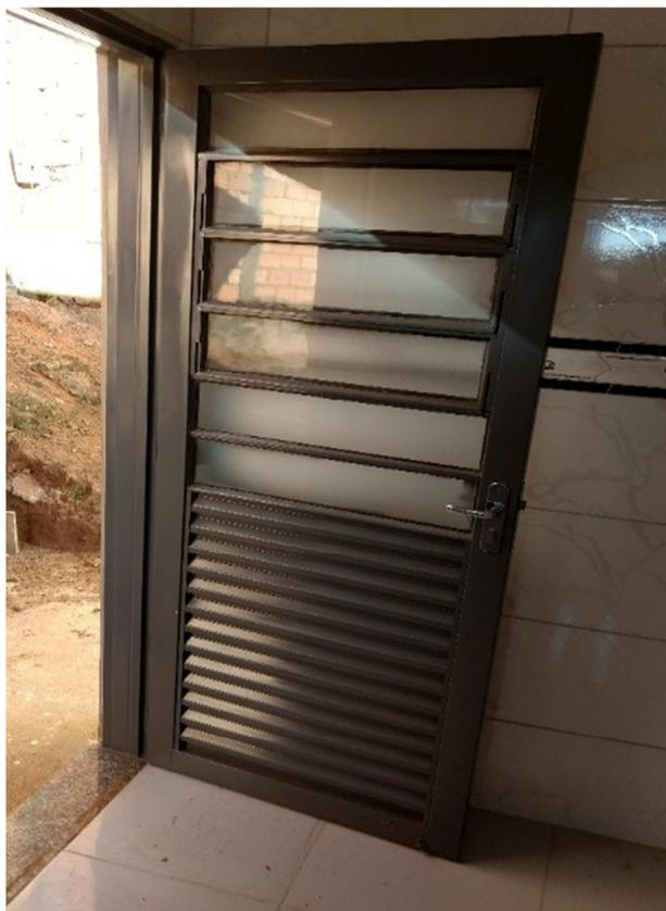
Figura 22: Esquadria metálica aplicada na obra.
