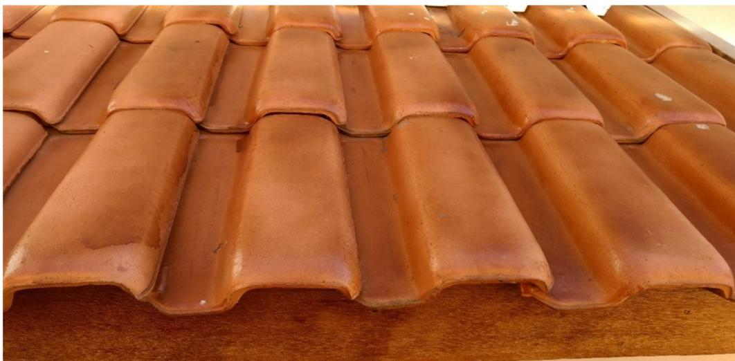
Figura 19: Telhado com telhas de cerâmica, vista por cima.
