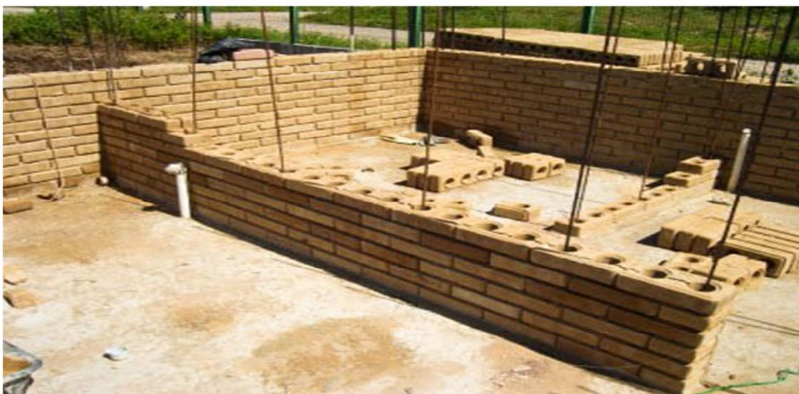
Figura 17: Parede feita com tijolo de solo cimento.
