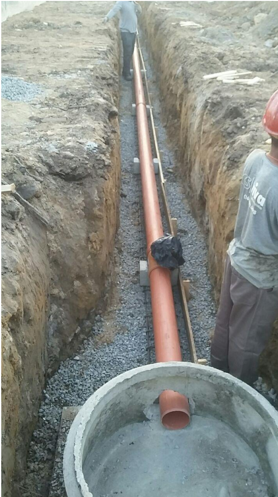
Vala com tubulação de uma obra no litoral brasileiro.
