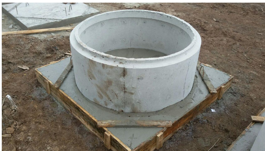
Execução da sub base dos PVs de uma obra no litoral brasileiro.
