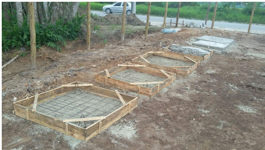
Preparação para execução da base dos PVa para a obra de uma obra no litoral brasileiro.
