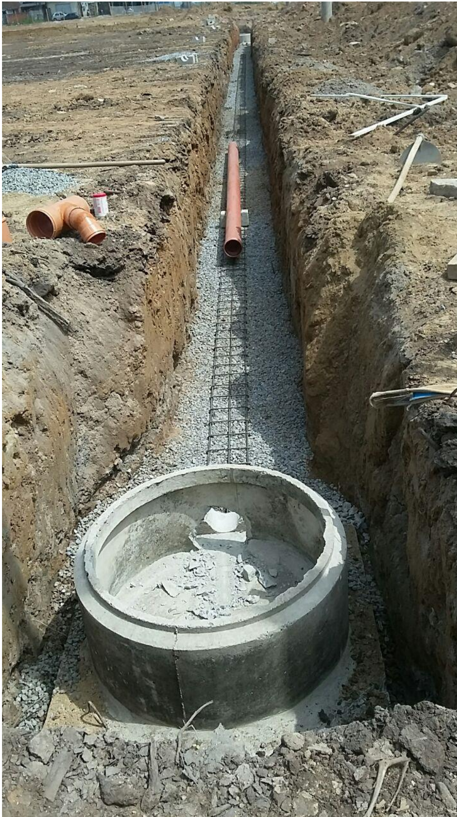
Sub base do PV locada e vala de passagem de tubulação de uma obra no litoral brasileiro.
