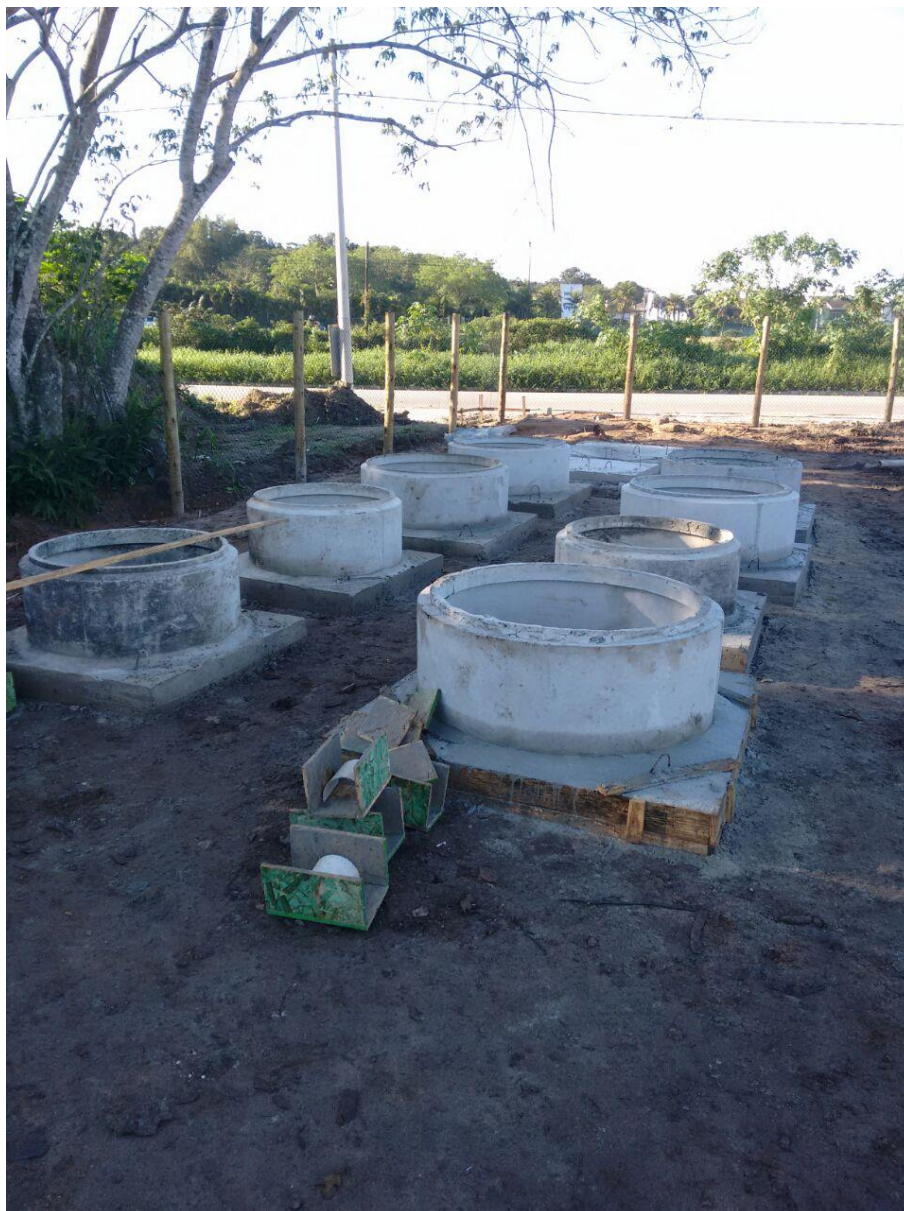
Preparação dos PVs de uma obra no litoral brasileiro.
