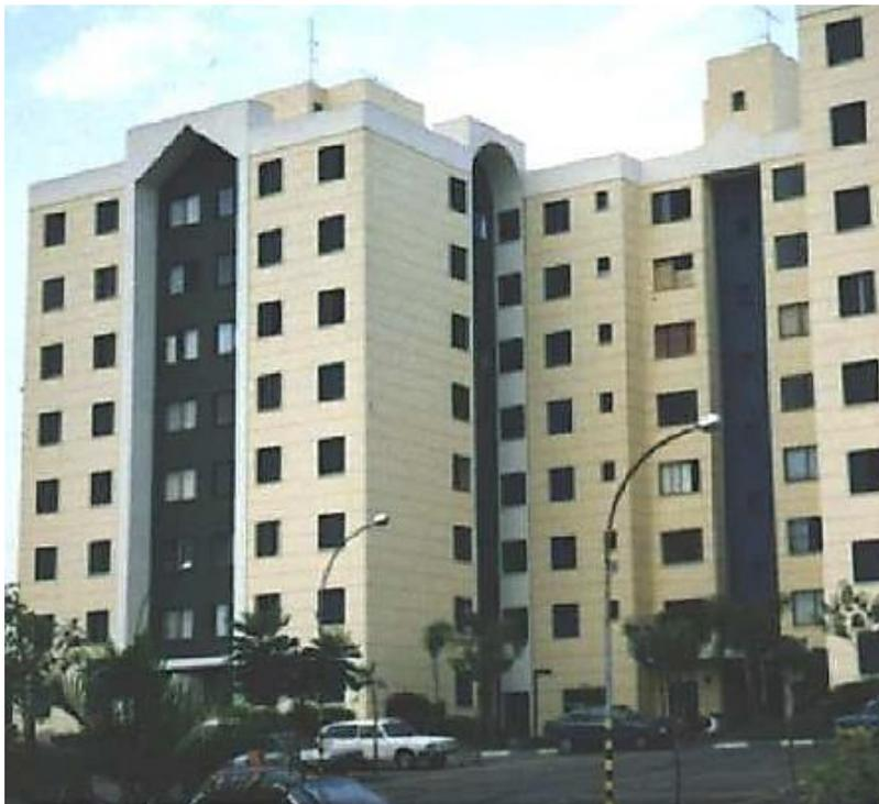
**Figura 1:** Conjunto de prédios com 8 pavimentos construídos em alvenaria não armada
