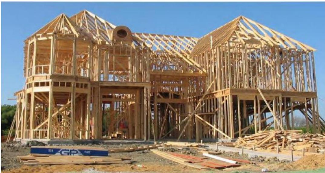
**Figura 8:** Sistema construtivo *wood frame*
