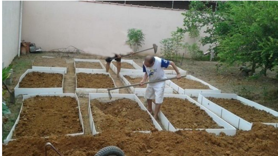
Figura 7 - Preenchimento da área interna dos canteiros. Fonte: O autor, 2016. (Acervo pessoal)
