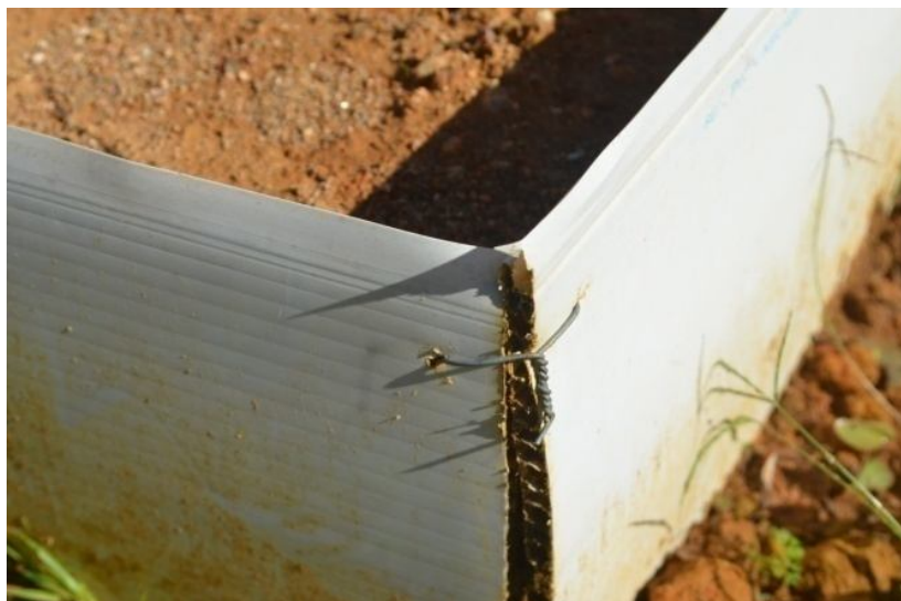
Figura 4 - Amarração da estrutura dos canteiros.
