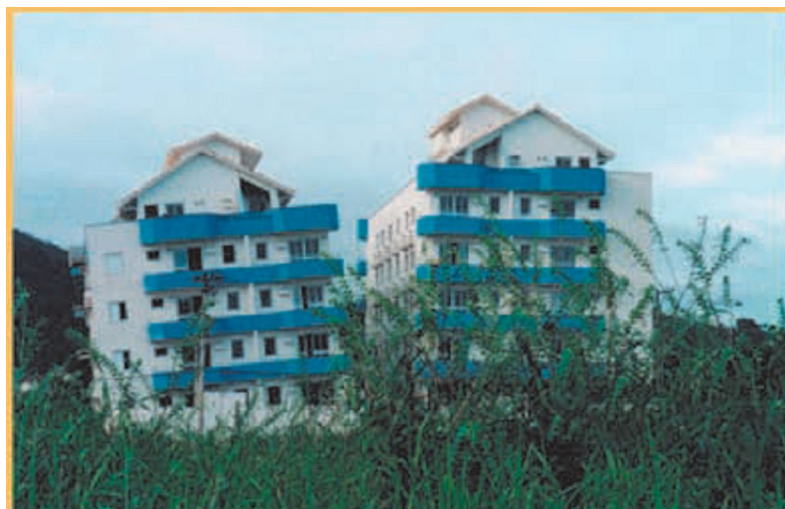
Figura 7: Imagem de prédio na praia das Toninhas que sofreu problemas por solo colapsível.
