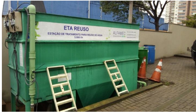
Figura 6: ETA – Estação de tratamento de água (reuso), para efluentes oleosos e com abrasivos provenientes do uso industrial e comercial em diversas aplicações.
