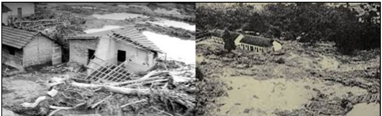
Figura 8: Imagens dos estragos causados pela Tromba D’água, ou Catástrofe, de 1967.
