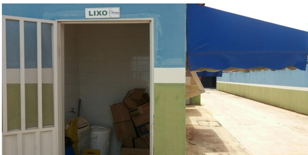
Figura 3: Local de armazenamento externo temporário, UBSF Colina Park, Prata, Minas Gerais.
