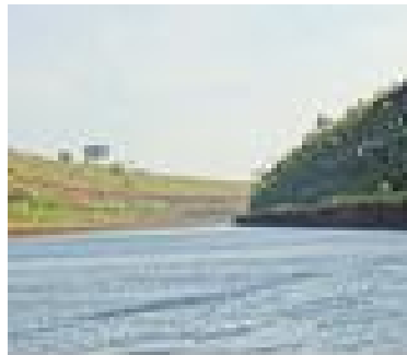
Figura 15 Canal de Pereira Barreto
