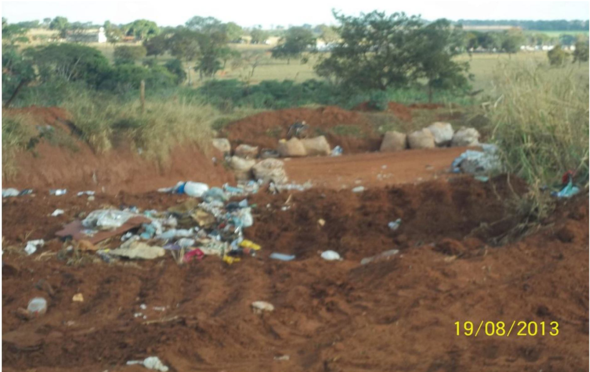
Figura 5: Vala com compactação realizada
