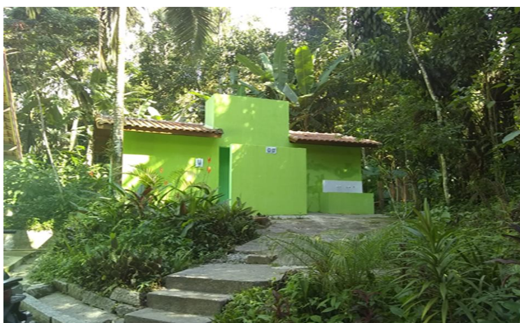
Figura 21: Sanitários e Bebedouro localizados no centro do parque Fonte: acervo da autora. 2019.
