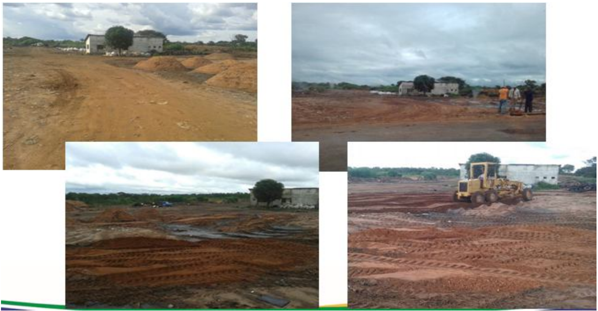
Figura 5. Lixão em Guaraí – TO após início das intervenções
