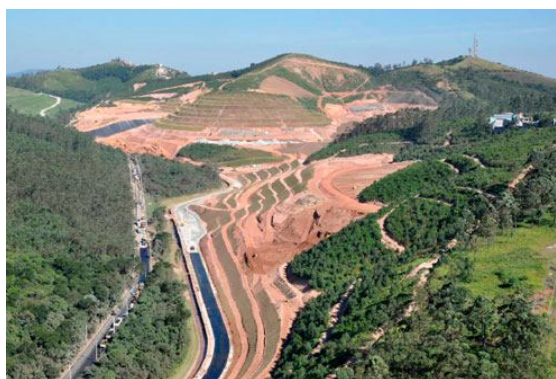
Figura 5: Aterro Sanitário em São João – SP
