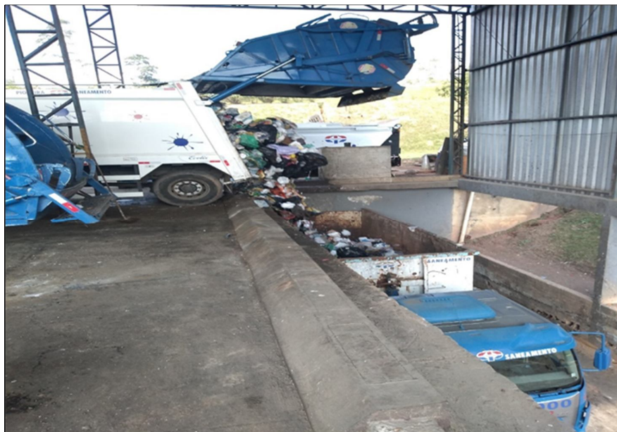
Figura 8 – Transferência dos resíduos dos caminhões coletores para as carretas
