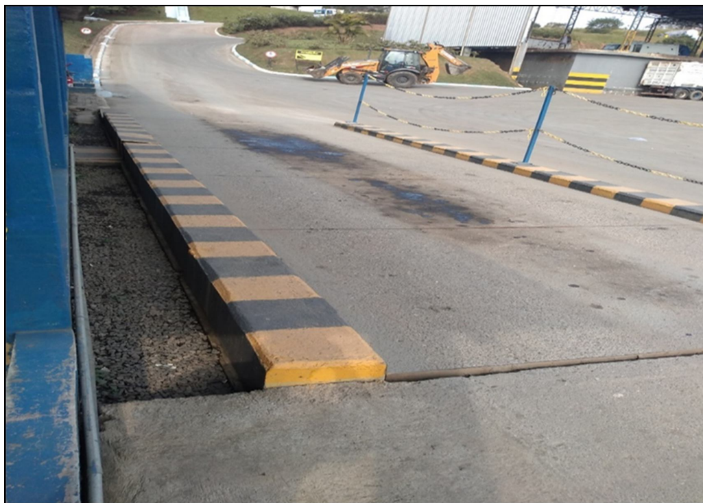
Figura 6 – Balança rodoviária da Estação de Transbordo de Resíduos
