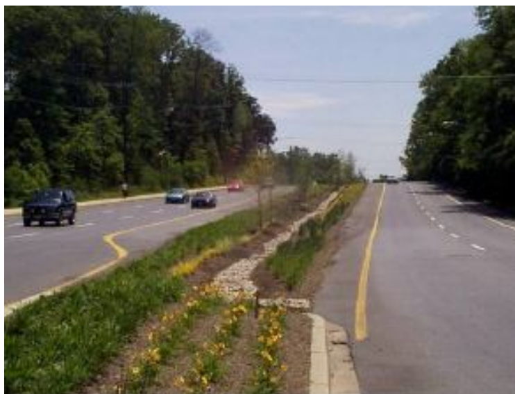
Figura 2. Trincheira de infiltração Fonte: Lucas (2011)
