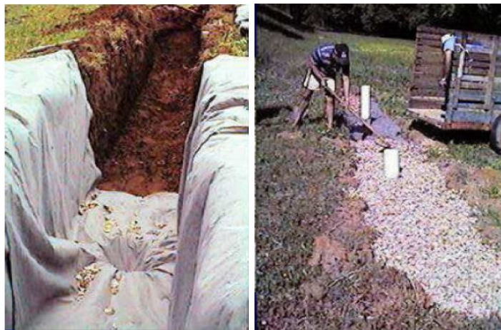
Figura 4. Poço de infiltração Fonte: Kobayashi et al. (2008)
