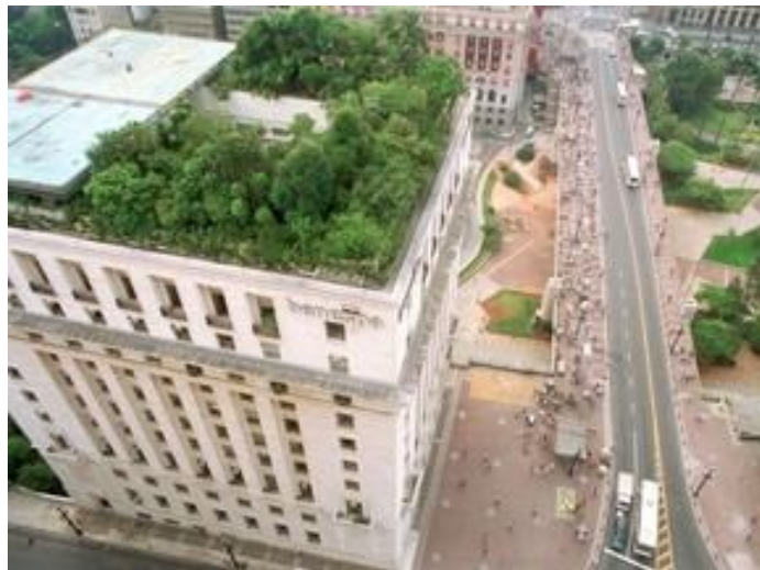
Figura 5. Telhado Verde Fonte: Câmara Municipal de São Paulo (2015)
