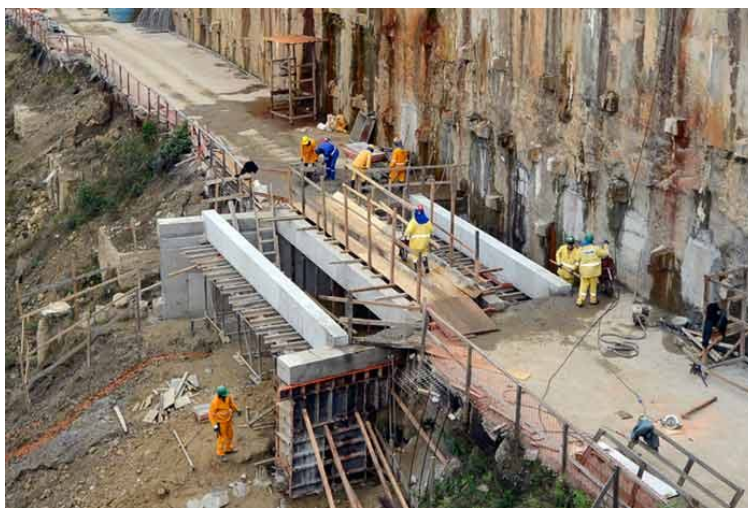
Figura 1. Construção do piscinão no centro de São Bernardo do Campo Fonte: São Bernardo do Campo (2020a)
