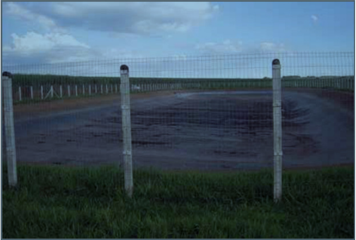
Figura 2 Tanque secundário impermeabilizado com geomembranas para recebimento e distribuição de vinhaça.
