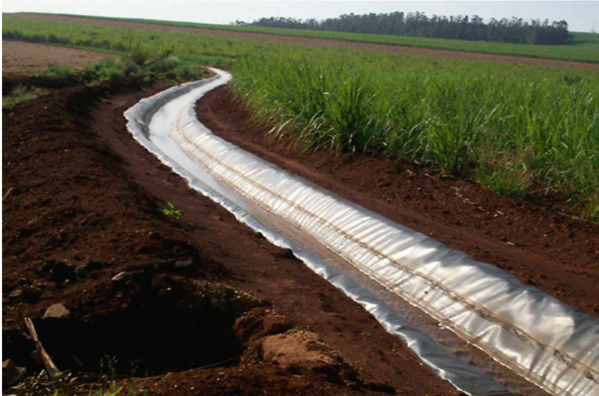
Figura 3 Canal de vinhaça impermeabilizado com geomembranas no formato trapezoidal. Fonte: Portal, 2014b.
