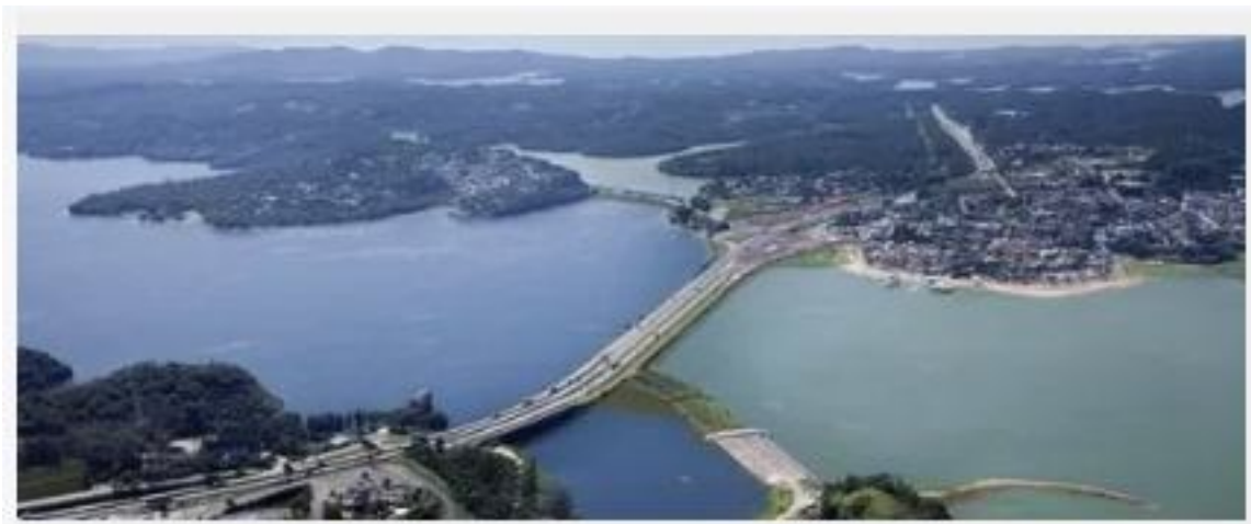
Figura 4: Barragem Anchieta - Do lado esquerdo está a captação de água. No lado direito está o bairro do Riacho Grande
