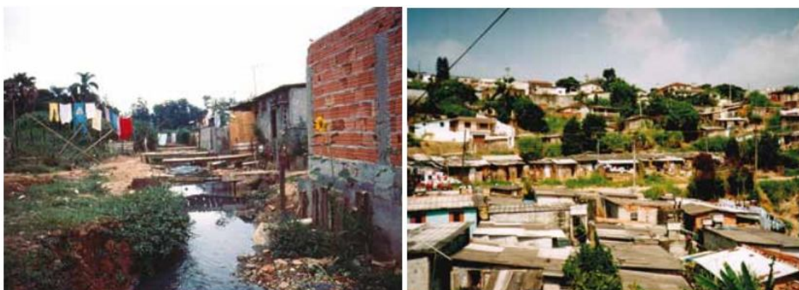
Figura 8: ARA 1 Habitações em condições precárias de saneamento ambiental.
