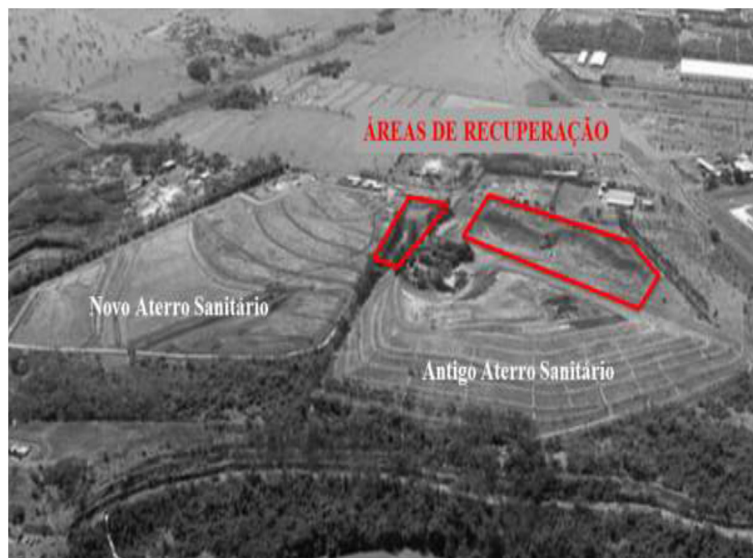
Figura 7. Aterro Sanitário de Uberlândia – MG. Fonte: Secretaria Municipal de Serviços Urbanos/2013
