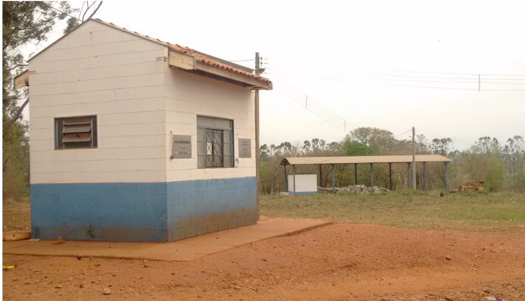
Figura15: Abrigo para o armazenamento externo dos RSS nas dependências do aterro sanitário. Fonte: A Autora (2019). (Acervo pessoal).
