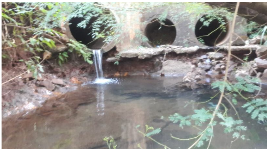
Figura 7 – Canalização do córrego Cabaça. Fonte: A autora (2018).
