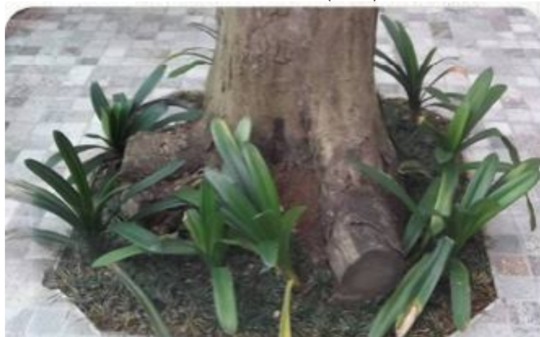
Figura 11: Errado: Poda de raízes de sustentação, causa de problemas estruturais.
