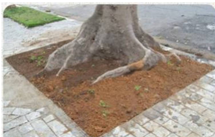
Figura 14: Correto: Abertura de canteiro, maior espaço para raízes e aumento de área permeável. Fonte: São Paulo (2012)
