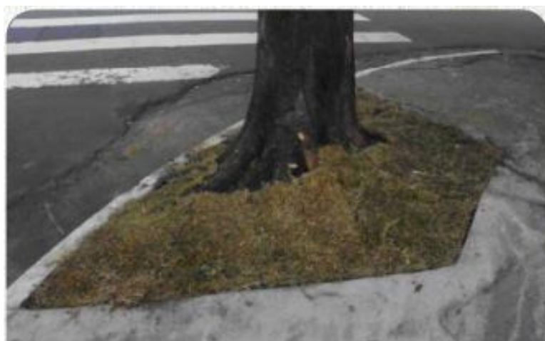
Figura 12: Correto: Ampliação de canteiros, evitando-se o corte de raízes.
