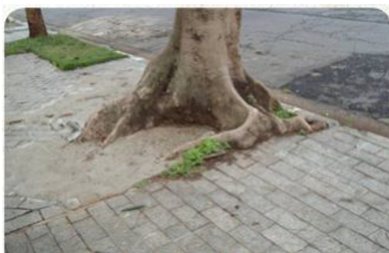
Figura 13: Errado: Sufocamento da raiz, impermeabilização e futuros problemas com quebra de calçada.
