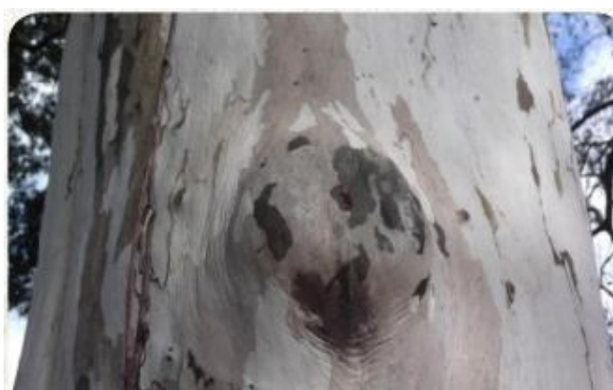
Figura 6: Correto: Poda adequada possibilita fechamento total da lesão. Fonte: São Paulo (2012)
