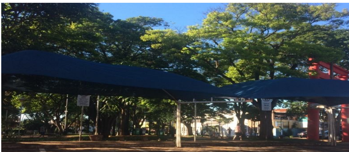
Figura 28 – Praça São Bento - ponto de táxi coberto de estrutura metálica e lona de proteção. Fonte: A autora (2017).
