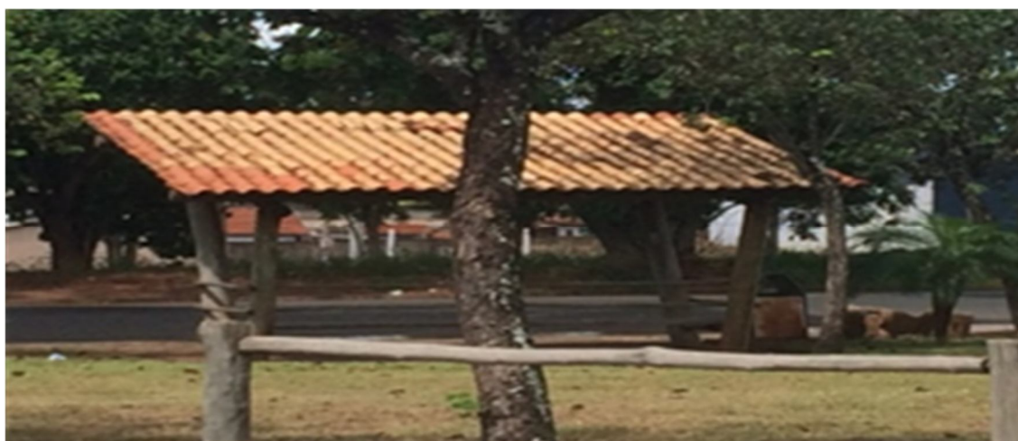
Figura 29 – Praça José Sanches Peres - ponto de ônibus de eucalipto tratado e cobertura em telhas cerâmicas. Fonte: A autora (2017).
