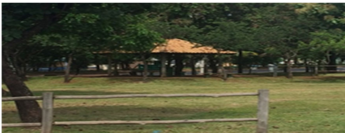
Figura 39 – Praça Helena Maria Arena dos Santos - Quiosques de eucalipto tratado com telhas cerâmicas para atividades de recreação. Fonte: A autora (2017).
