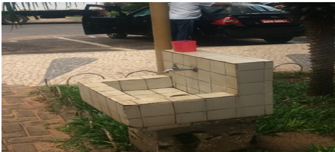
Figura 18 – Praça São Judas Tadeu - Bebedouro de alvenaria revestido em cerâmica, com torneira e sem refrigeração. Fonte: A autora (2017).
