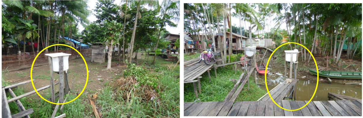
Figura 8. Solução Alternativa Individual utilizada para coleta de água do igarapé no município de Afuá-PA.
