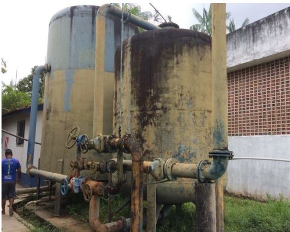
Figura 15. Tanques da Estação de Tratamento de Água - ETA da COSANPA que não estão em funcionamento no município de Afuá.
