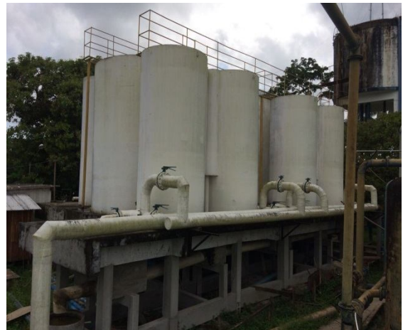
Figura 15. Tanques da Estação de Tratamento de Água - ETA da COSANPA que não estão em funcionamento no município de Afuá.
