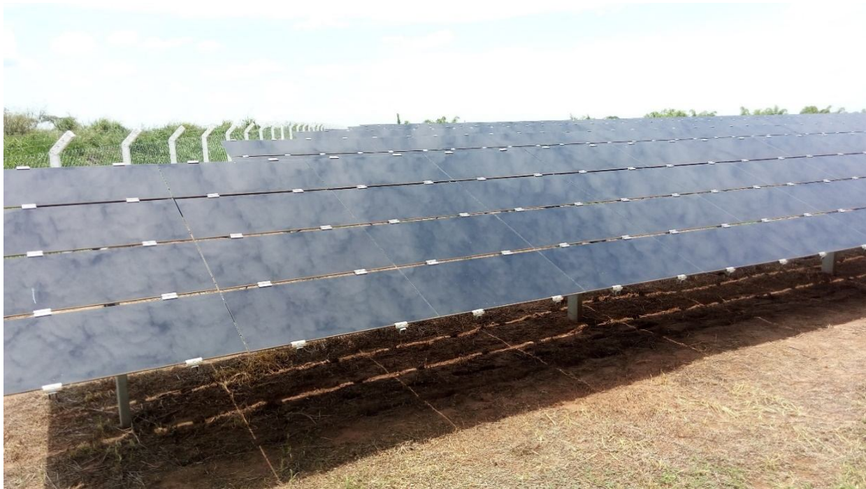
Figura 16: Painéis de silício monocristalino - Usina FV da Universidade Brasil em Fernandópolis/SP (2018).
