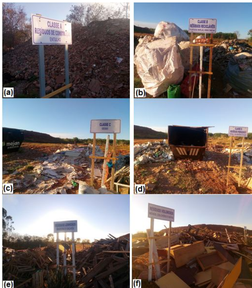
Figura 9 – Separação dos resíduos e disposição de acordo com a sua classe no aterro de Jales/SP - (a): Classe A - RCC; (b): Classe B - Recicláveis; (c): Classe C – Gesso; (d): Classe D – Tintas, solventes e óleos; (e): Classe Lenhosos; (f): Classe Volumosos. Fonte: Próprio autor, 07/2017.
