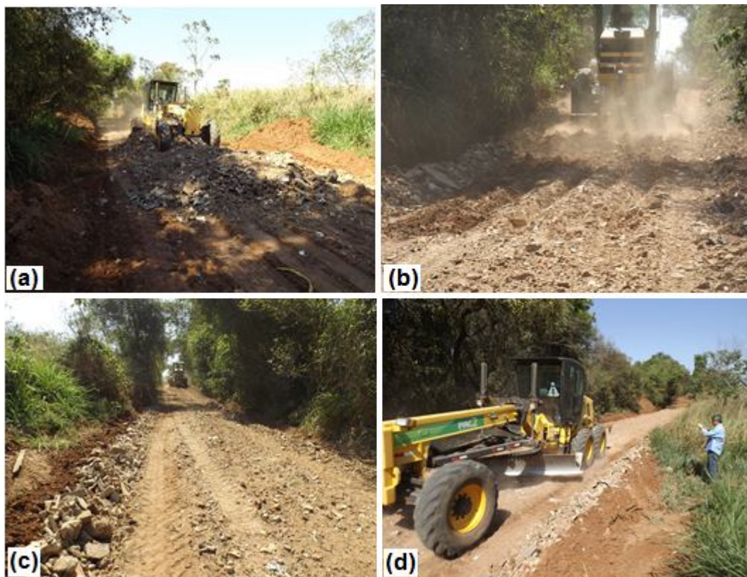
Figura 13 – Motoniveladora – trecho da estrada rural pavimentada com RCC – (a): Início do nivelamento; (b): Motoniveladora realizando o nivelamento com o RCC depositado; (c) e (d): Trecho nivelado. Fonte: Próprio autor, 2017.
