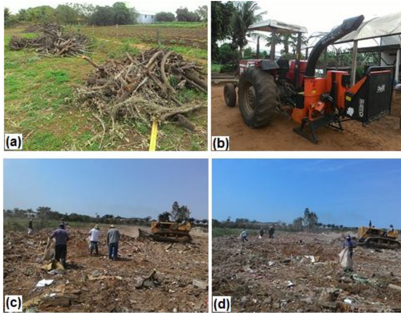
Figura 8 – Separação dos materiais entregues no aterro de RCC – (a): galhos; (b): triturador de galhos acoplado a um trator; (c; d): equipe separando o RCC. Fonte: Próprio autor, 07/2017.
