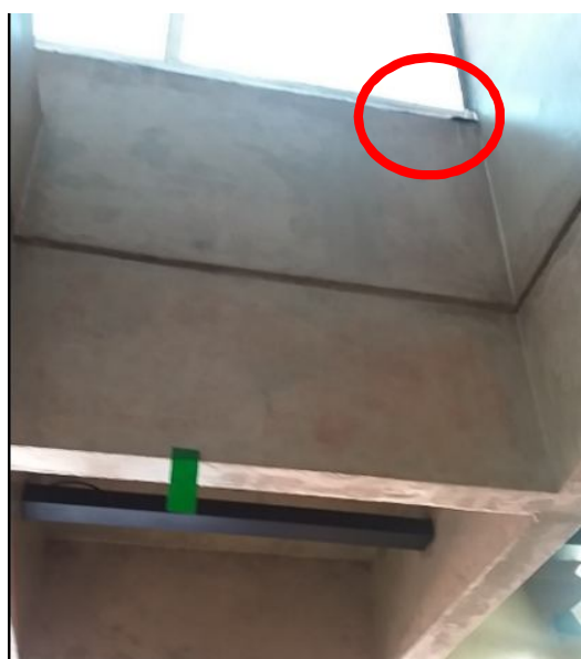
Figura 1 – Descolamento da claraboia.
