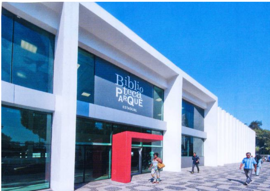
Figura 9 – Biblioteca Parque Estadual – Fachada frontal. Fonte: SAYEGH e BRANDO (2014, p. 31).
