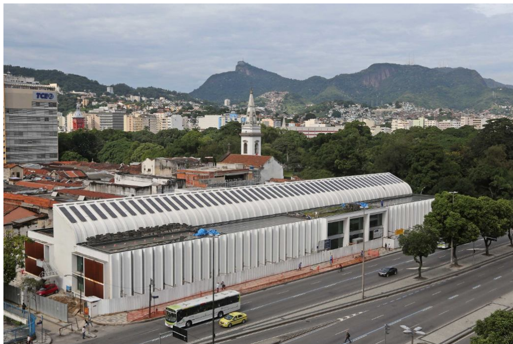
Figura 15 – Biblioteca Parque Estadual – Placas fotovoltaicas – telhado. Fonte: RIO DE JANEIRO, RJ (2016).
