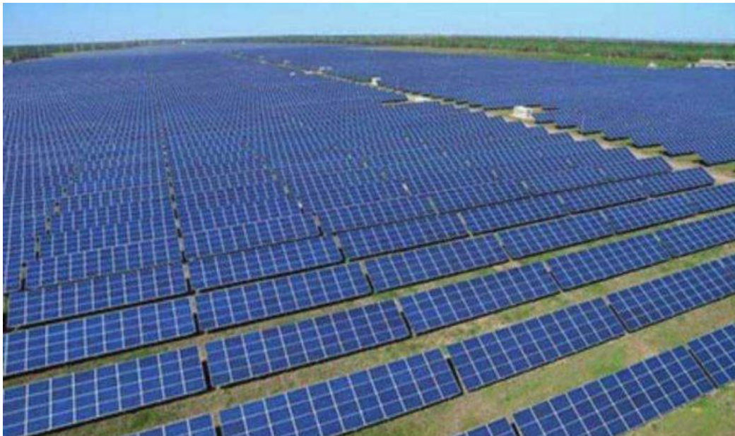
Figura 9: Usina Fotovoltaica Nova Olinda em Ribeira do Piauí - PI. Fonte: Liga da Energia Solar ( www.ligasolar.com ).
