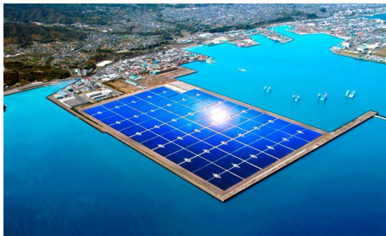
Figura 6: Usina Solar de Kagoshima Nanatsujima com capacidade de 70 MW.
