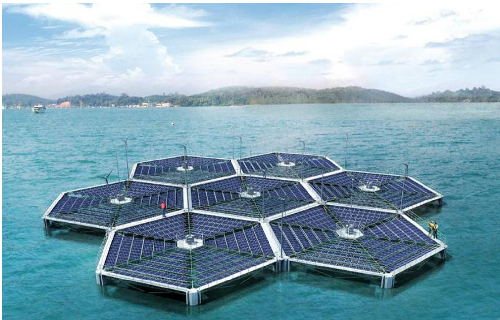
Figura 8: Usina flutuante de 10 MW em Kerala, Índia.
