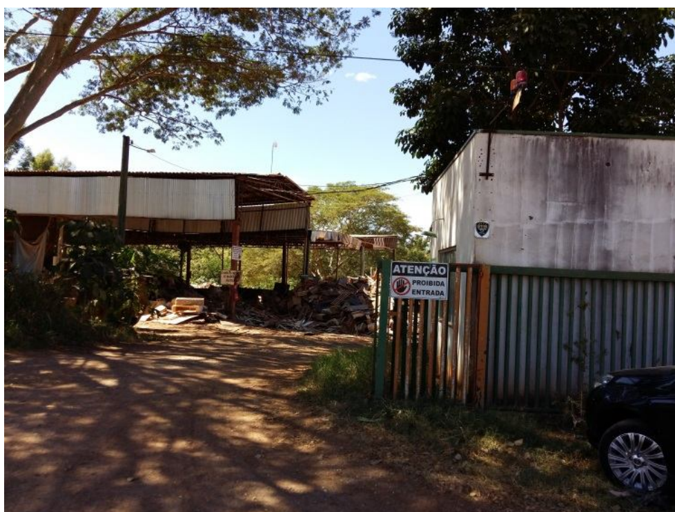
Figura 22: Fachada da Usina de Reciclagem Mejan Ambiental.
