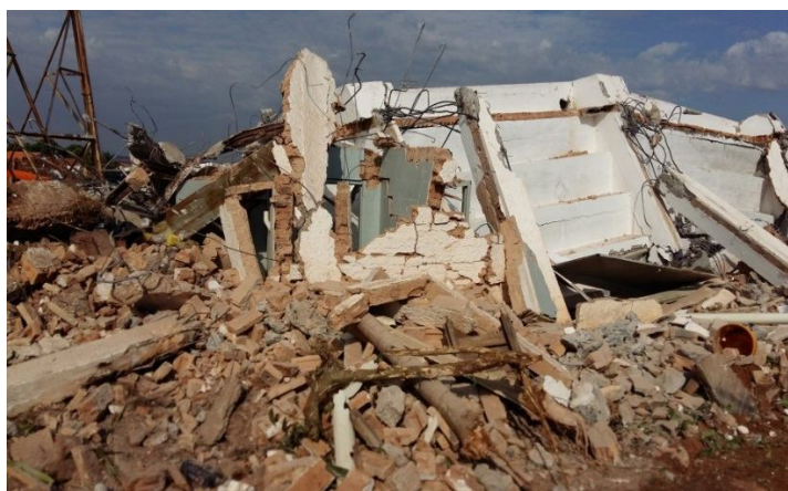
Figura 27: Demolição do estádio Plínio Marin – Votuporanga-SP. Fonte: O autor, 2016.
