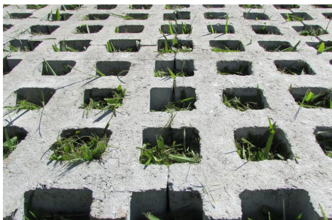
Figura 17: Piso ecológico (pavimentação).
