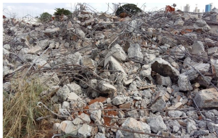
Figura 26: Demolição do estádio Plínio Marin – Votuporanga-SP. Fonte: O autor, 2016.
