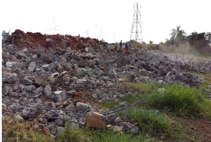
Figura 25: Demolição do estádio Plínio Marin – Votuporanga-SP. Fonte: O autor, 2016.
