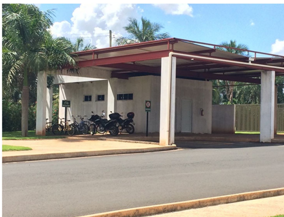
Figura 8: Bicicletário do Bairro Morada do Sol, Uberlândia MG, 2017
