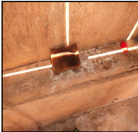
Figura 8: Materiais limpeza inadequado.
