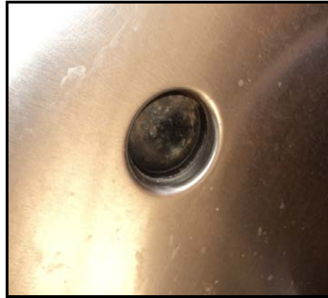
Figura 7: Falhas de Higiene na tampa, face interna do tanque.
