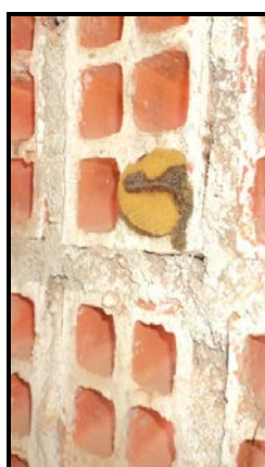
Figura 13: Utensílios em local inadequado
