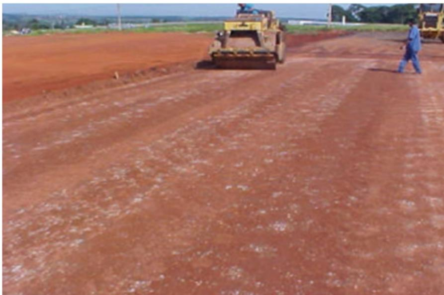
Figura 15: Base executada com agregado
