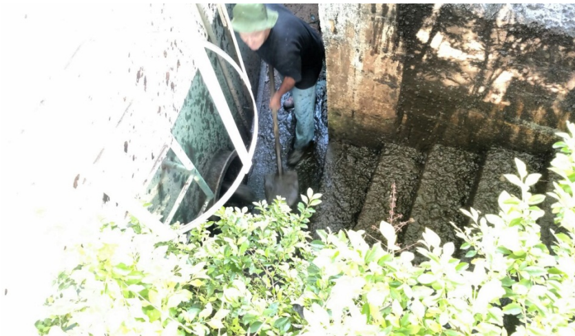
Figura 7 – Retirada manual do lodo do tanque de reciclagem.
