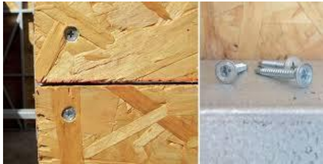
Figura 9: Fixação dos painéis de Wood Frame. Fonte: techne.pini.com.br
