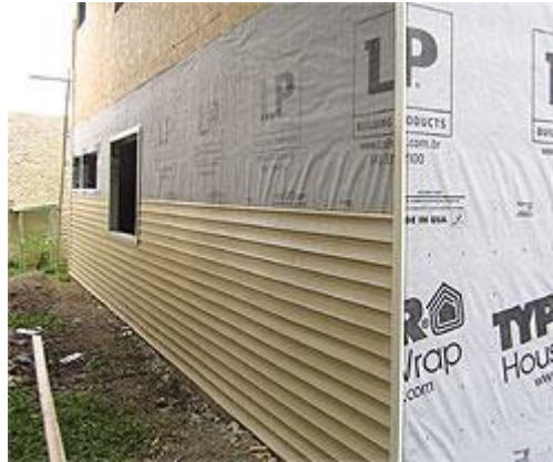
Figura 12: Fixação de membrana impermeável sobre as chapas de OSB. Fonte: techne.pini.com.br
