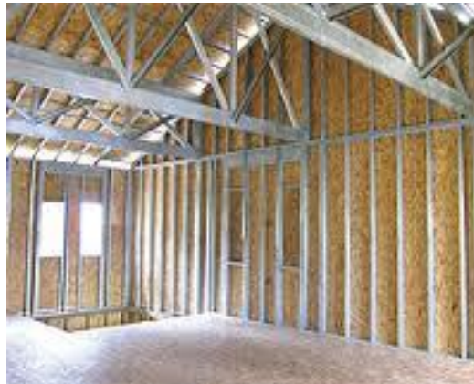
Figura 5: Montagem do quadro estrutural Fonte: techne.pini.com.br
