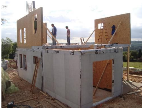
Figura 6: Montagem dos quadros estruturais em obra. Fonte: techne.pini.com.br
