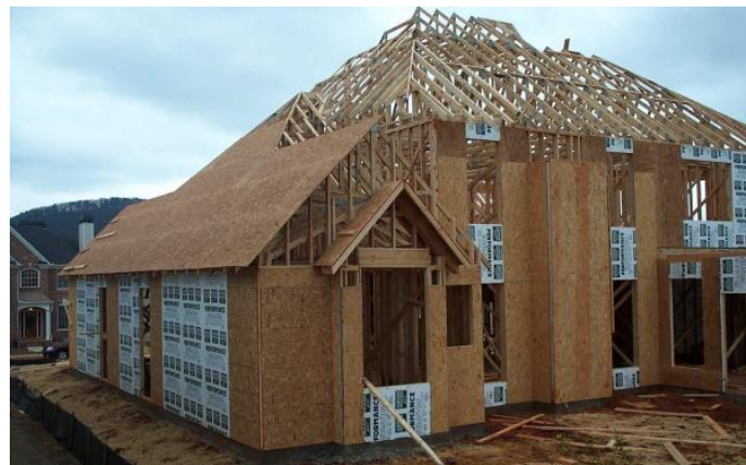
Figura 15: Estrutura de uma casa em Wood Frame . Fonte: Revista Técnica PINI – Edição 161 – Agosto/2010.
