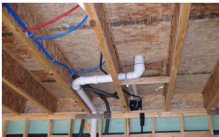
Figura 17: Instalação da parte elétrica e hidráulica em uma construção de Wood Frame . Fonte: Revista Técnica PINI – Edição 161 – Agosto/2010.
