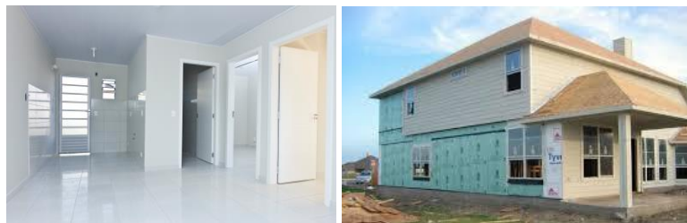
Figura 13: Instalação dos revestimentos internos e externos em construções em Wood Frame. Fonte: tecverde.com.br
