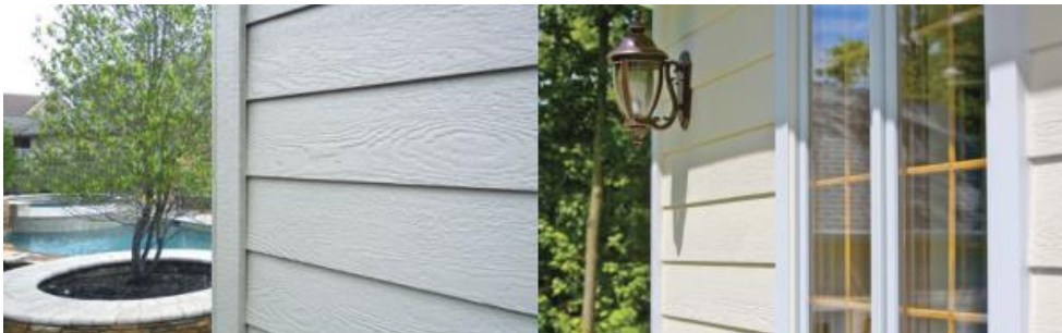
Figura 20: SIDING DE MADEIRA.
