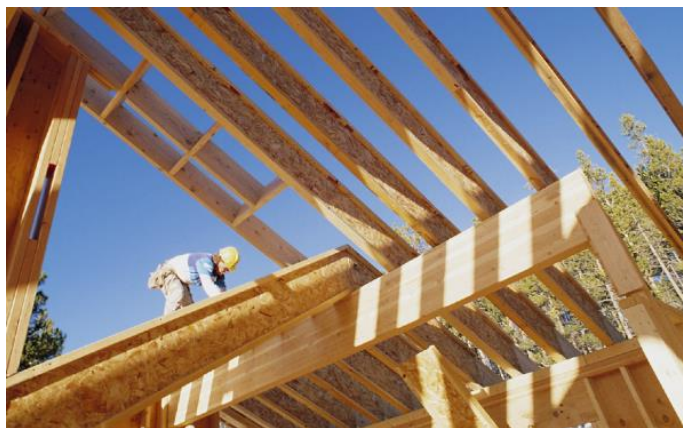
Figura 16: Placas estruturais são instaladas sobre o vigamento de madeira.
