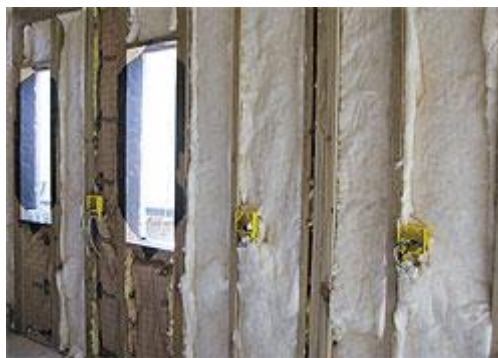
Figura 11: Fixação das placas ou mantas de isolamento térmico e absorção acústica Fonte: techne.pini.com.br
