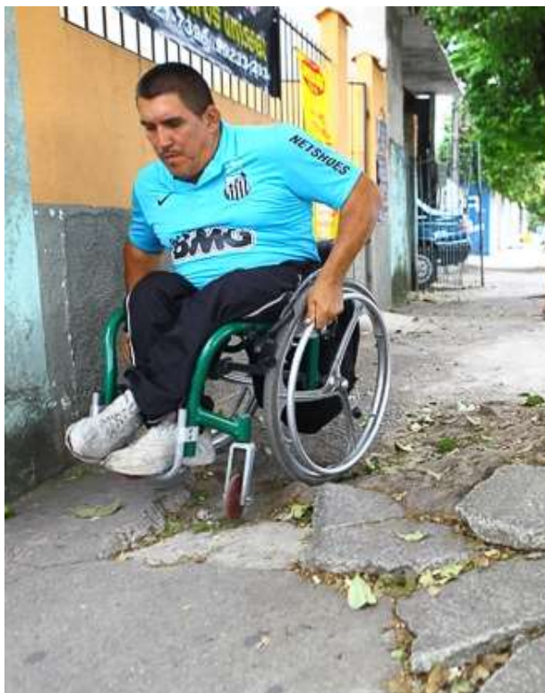
Figura 4: Calçadas sem acessibilidade Fonte: Rodrigues, 2014
