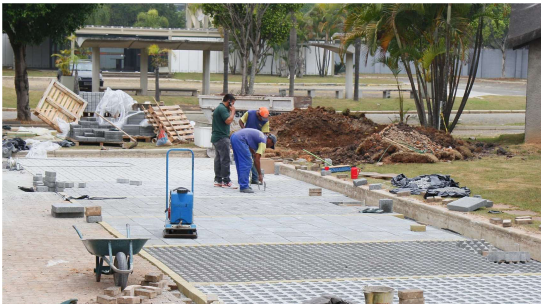
Figura 29: Compactação do revestimento. Fonte: ABCP (2017)
