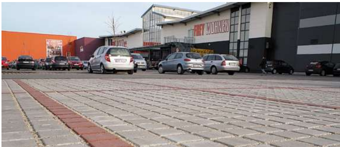
Figura 11: Pavimento permeável, Alemanha Fonte: http://www.huberstein.de/pflaster/standard-pflaster
