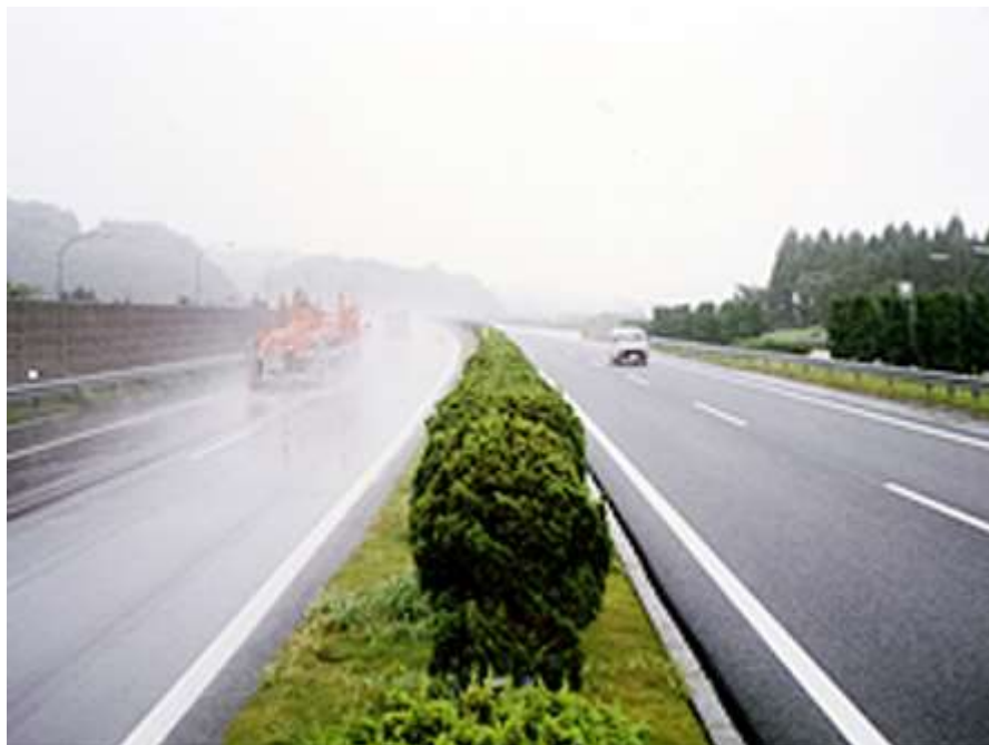
Figura 10: Autoestrada no Japão com piso permeável.
