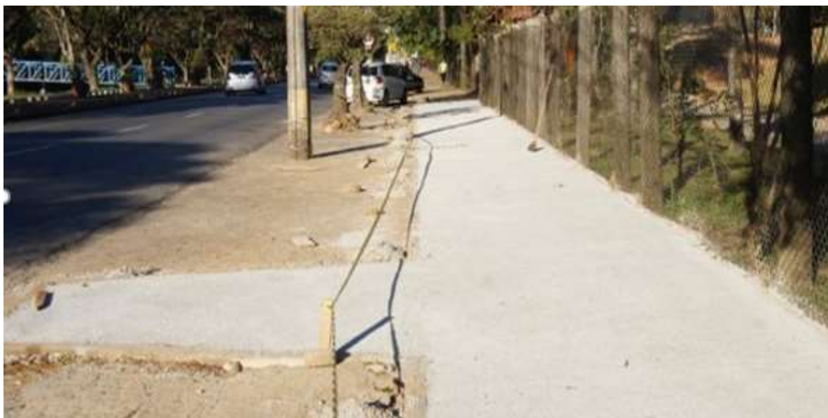
Figura 12: Calçada em concreto 100% permeável no Parque Municipal Antônio Molinari. Fonte: Prefeitura Poços de Caldas, MG (2014).
