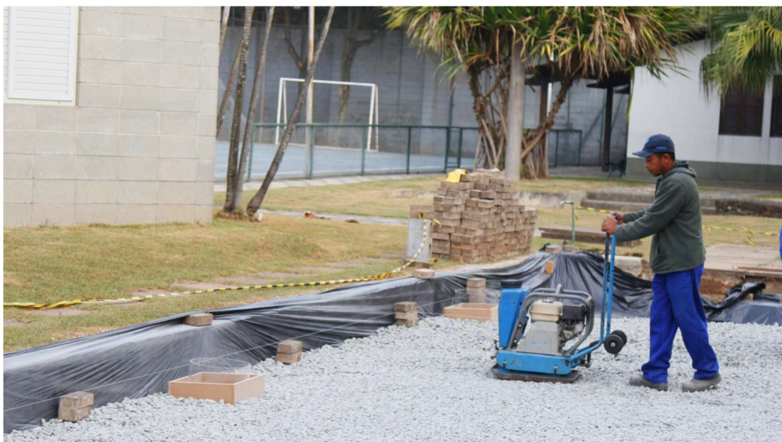
Figura 25: Colocação e compactação do material de base. Fonte: ABCP (2017)
