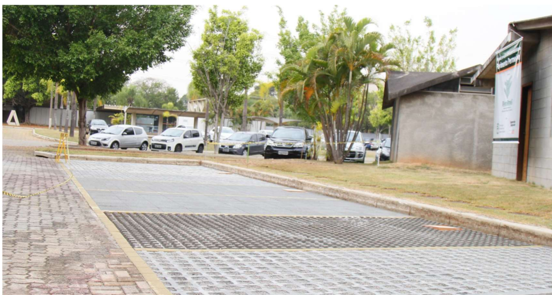
Figura 30: Limpeza, inspeção final e teste de permeabilidade Fonte: ABCP (2017)
