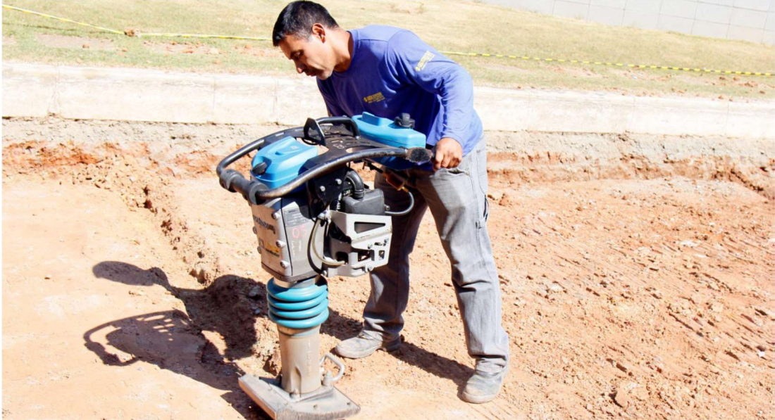
Figura 19: Compactação do solo Fonte: ABCP (2017)
