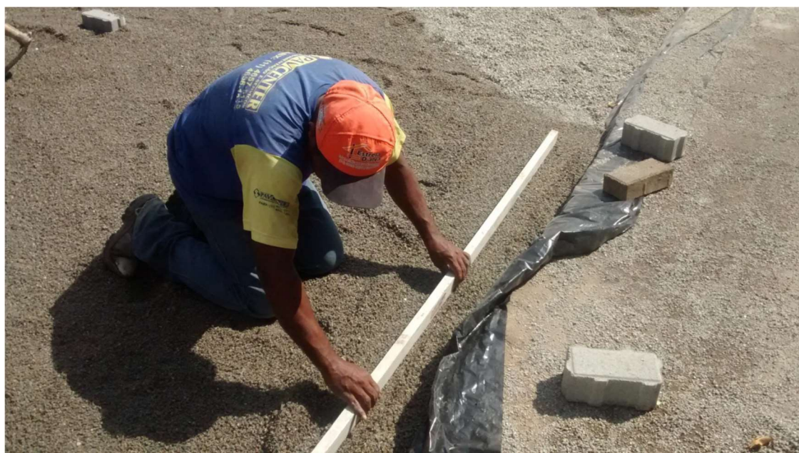
Figura 26: Colocação do material de assentamento. Fonte: ABCP (2017)
