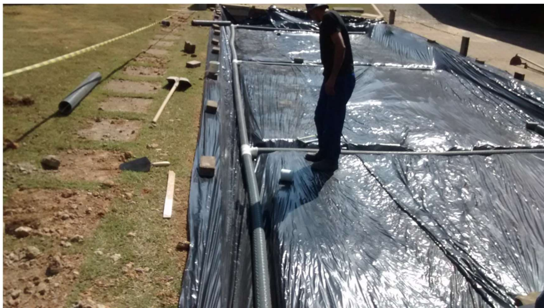
Figura 21: Instalação dos tubos de drenos Fonte: ABCP (2017)
