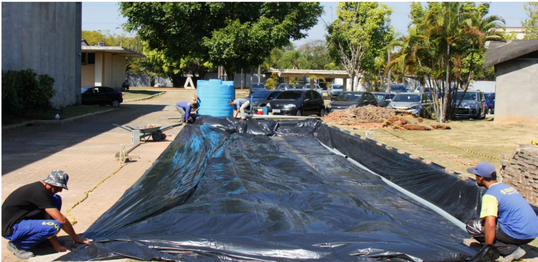
Figura 20: Colocação de manta impermeável para proteção do solo Fonte: ABCP (2017)
