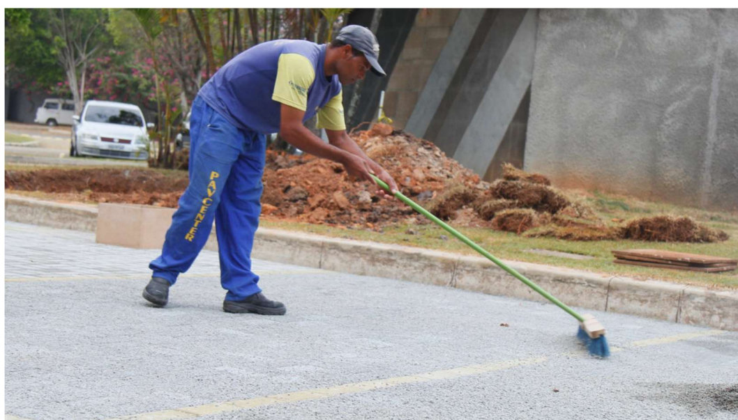
Figura 28: Espalhamento do material de rejuntamento. Fonte: ABCP (2017)
