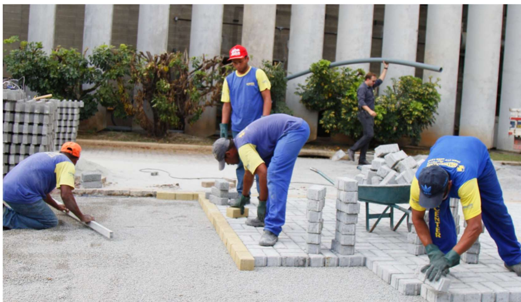
Figura 27: Colocação das peças de revestimento. Fonte: ABCP (2017)
