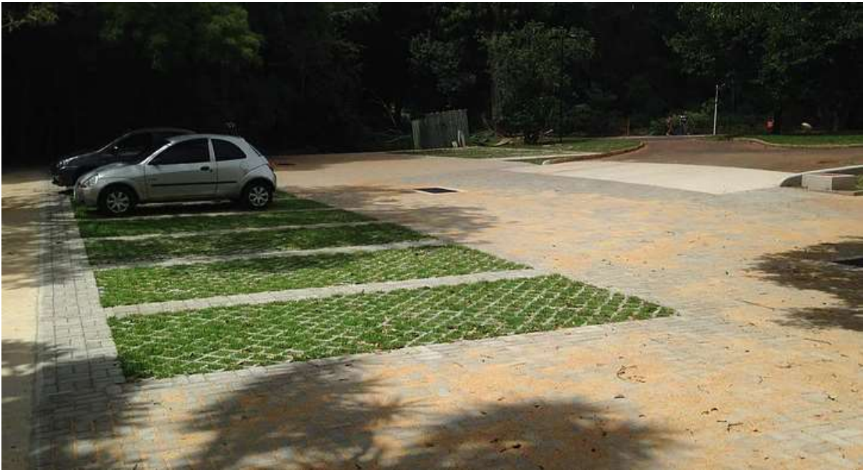
Figura 13: Pátio de estacionamento na Universidade Federal de São Carlos (UFSCAR). Fonte: https://www.pisosbriquet.com.br/obras?lightbox=dataItem-ixrkp4m51
