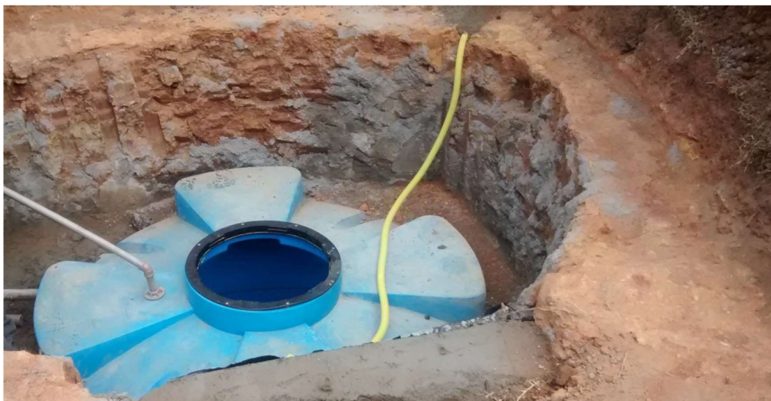
Figura 22: Instalação da cisterna. Fonte: ABCP (2017)
