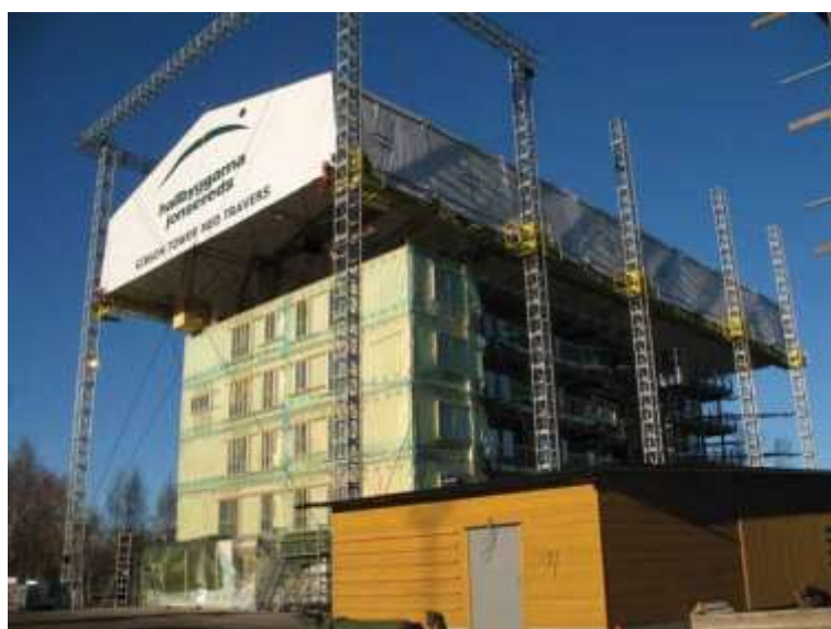
Figura 15 - Tenda de proteção. Fonte: Douglas e Karacabeyli (2013).
