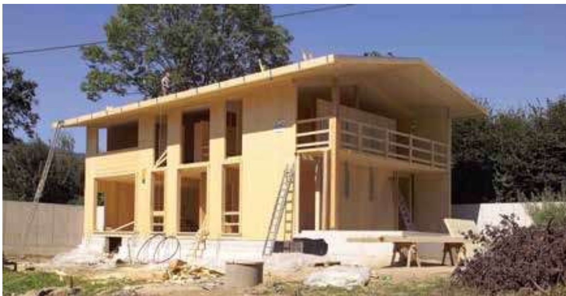
Figura 10 - Casa em construção com MLCC. Fonte: Douglas e Karacabeyli (2013).
