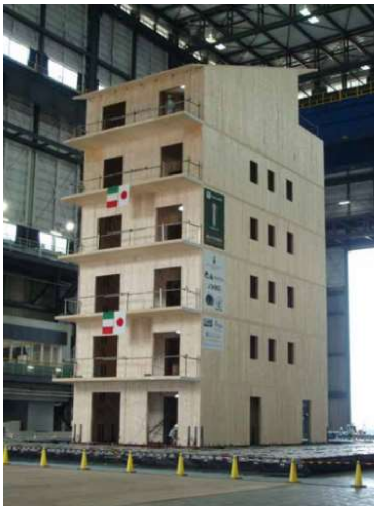
Figura 13 - Edifício MLCC de sete andares testado no E-Defense Laboratory em Miki, Japão. Fonte: Douglas e Karacabeyli (2013).
