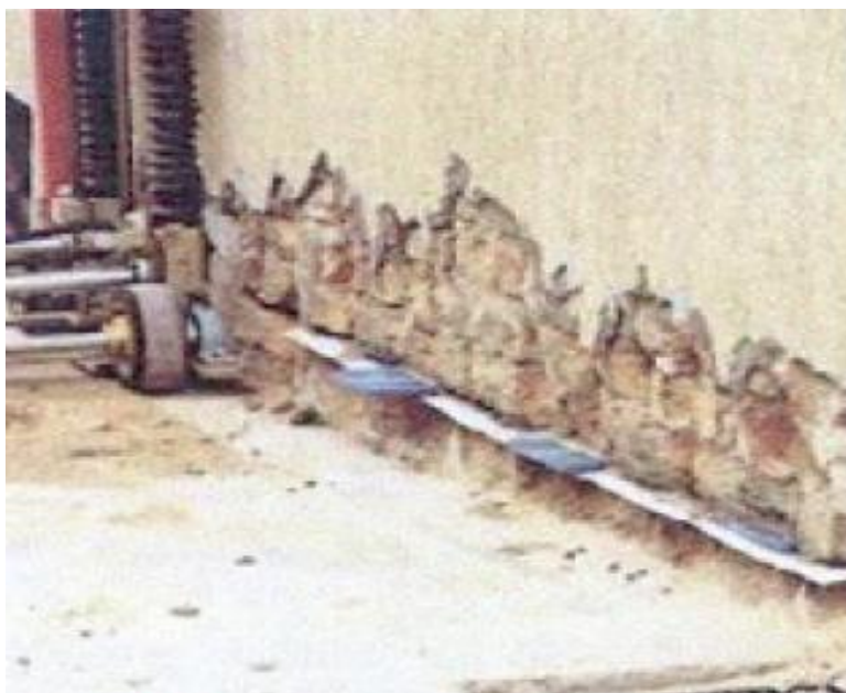
Figura 25 – Introdução de uma barreira estanque através do corte mecânico. Fonte: Magalhães (2008)
