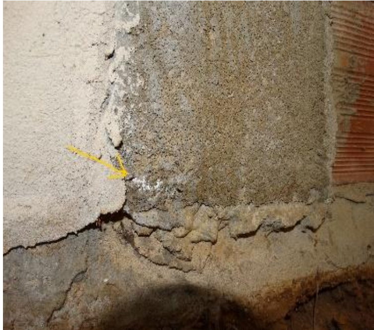
Figura 62 – Eflorescência formada na base do protótipo 2. Fonte: Arquivo Pessoal
