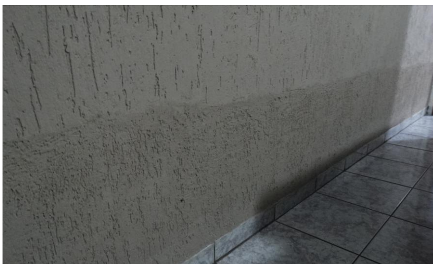
Figura 37 – Parede reparada recentemente. Fonte: Arquivo pessoal
