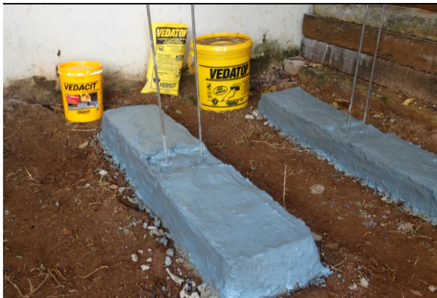
Figura 40 – Vigas que receberam aplicação de Vedacit e Vedatop.
