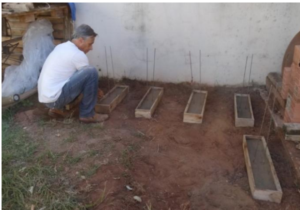
Figura 39 – Baldrames com 2 barras de ferro de \frac{1}{4} de polegada (630 mm). Fonte: Arquivo pessoal
