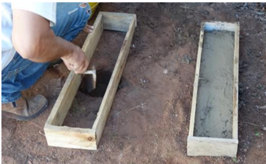
Figura 38 – Execução dos baldrames e broca. Fonte: Arquivo pessoal
