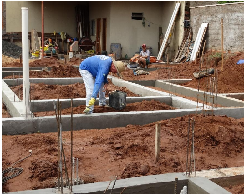
Figura 21 – Aplicação de Argamassa Polimérica em baldrame. Fonte: Arquivo Pessoal
