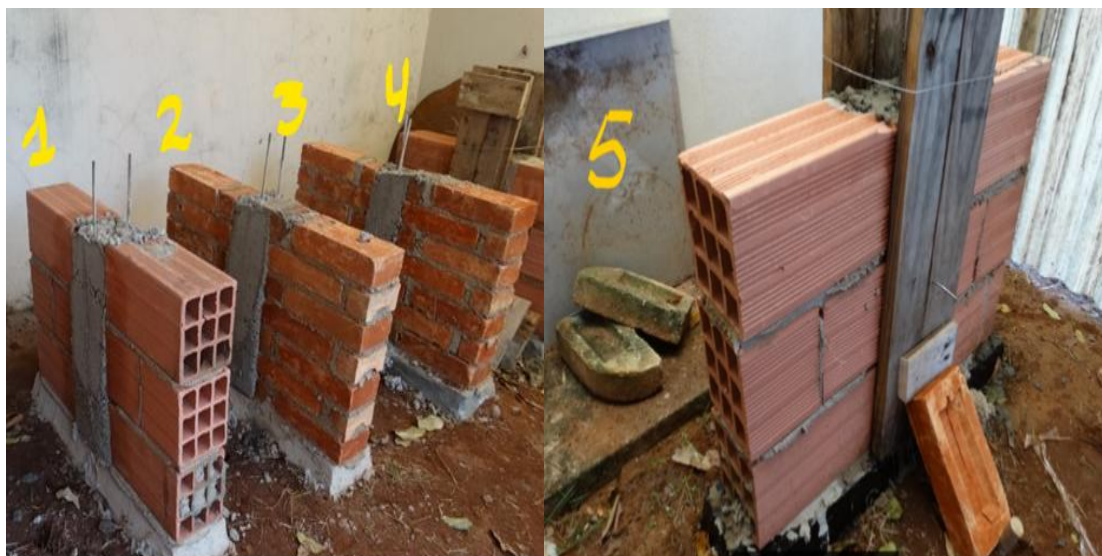
Figura 48 - Paredes e tipos de tijolos utilizados no ensaio.
