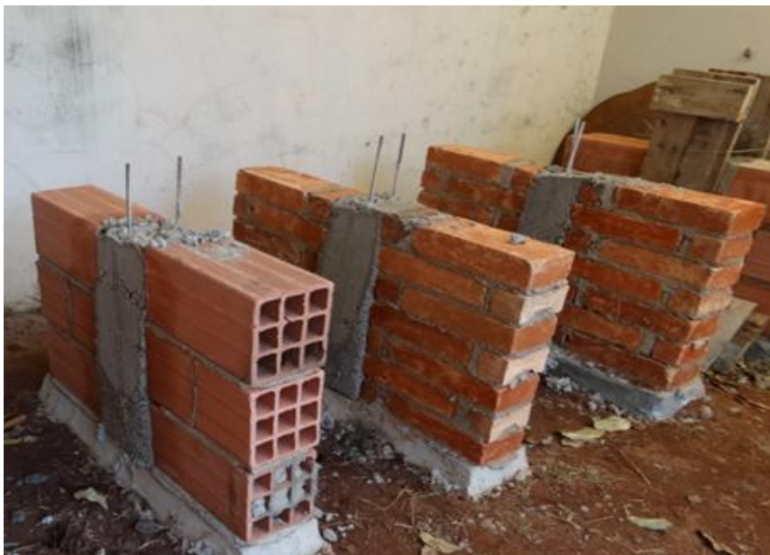
Figura 46 – Assentamento dos tijolos. Fonte: Arquivo pessoal
