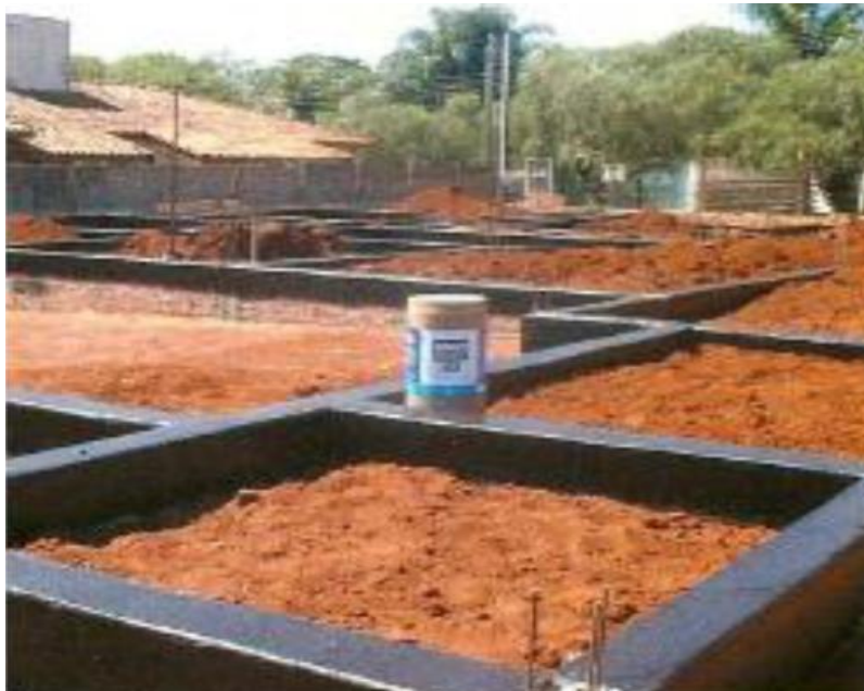
Figura 22 – Baldrame que recebeu aplicação de emulsão asfáltica. Fonte: Rodrigues (2014)
