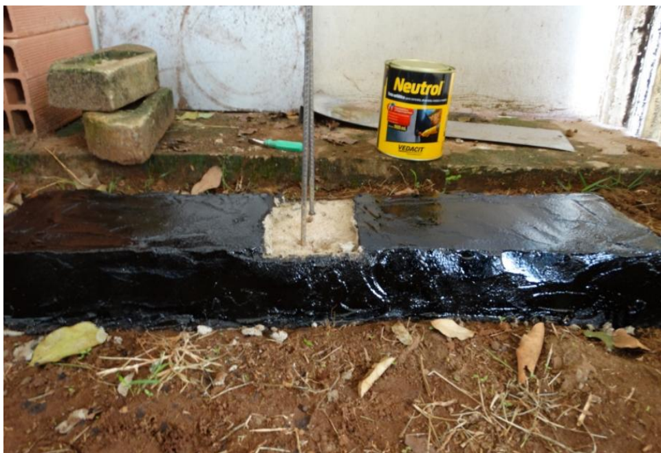
Figura 42 – Viga que recebeu aplicação de tinta asfáltica Neutrol. Fonte: Arquivo pessoal
