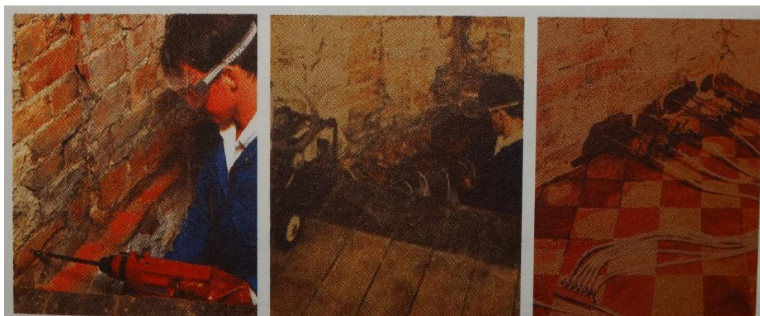
Figura 30 – Introdução de produtos por injeção. Fonte: Freitas et al. (2008)
