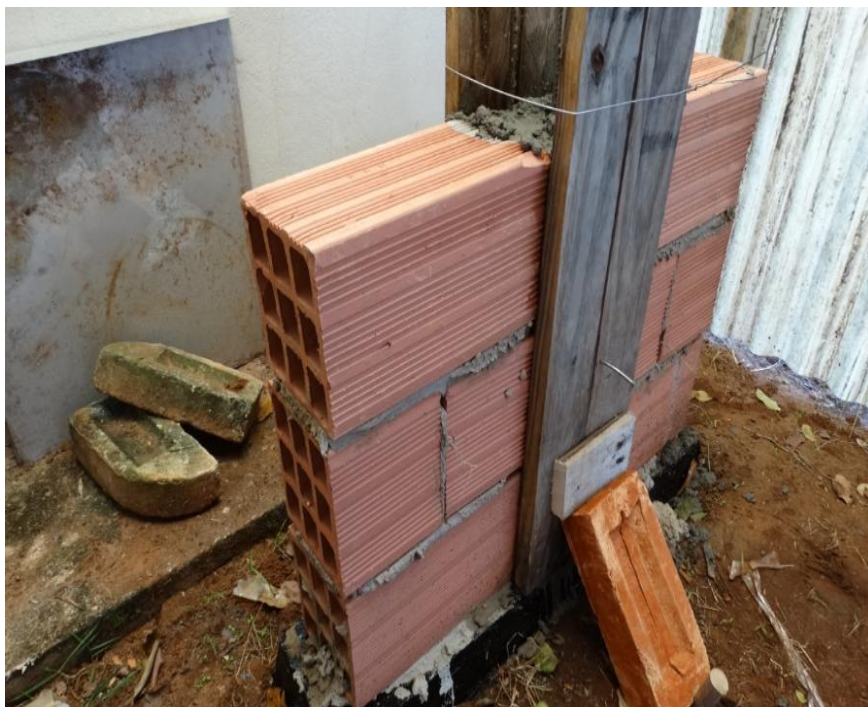
Figura 47 – Coluna confeccionada no centro da parede com o mesmo traço utilizado nos baldrames. Fonte: Arquivo pessoal
