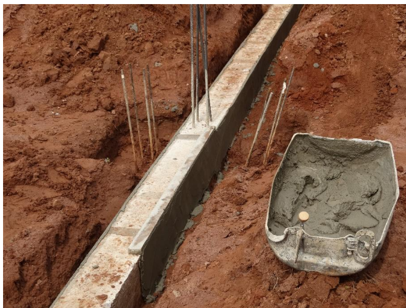
Figura 23 – Aplicação em baldrame de Argamassa com aditivo hidrofugante. Fonte: Arquivo Pessoal
