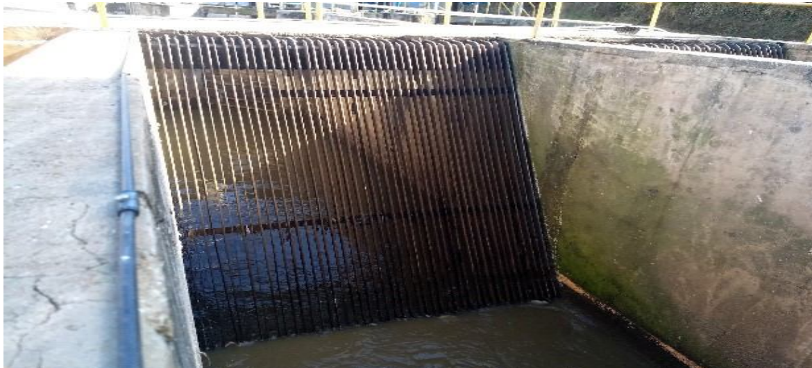
Figura 4 – Primeiro gradeamento - ETE Uberabinha, DMAE.
