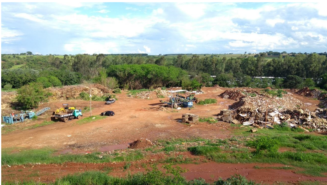
Figura 5 – Visão geral da área de recepção, triagem, aterro e processamento de RSCCVLU de Jales, com destaque para o picador dos resíduos lenhosos urbanos.
