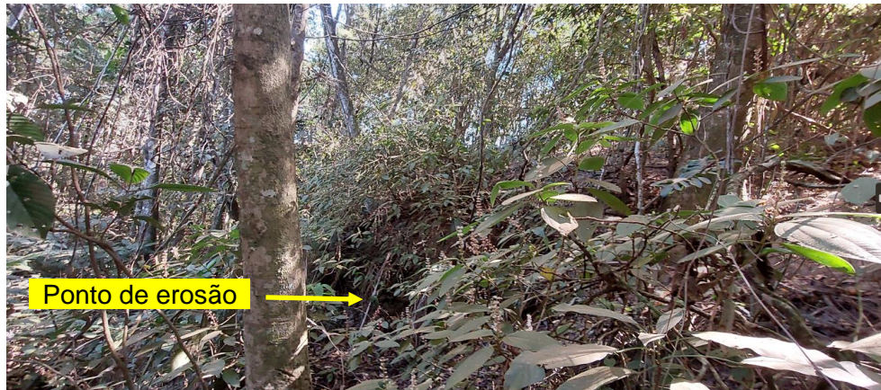
Figura 46 - Vista da vegetação e do ponto de erosão
