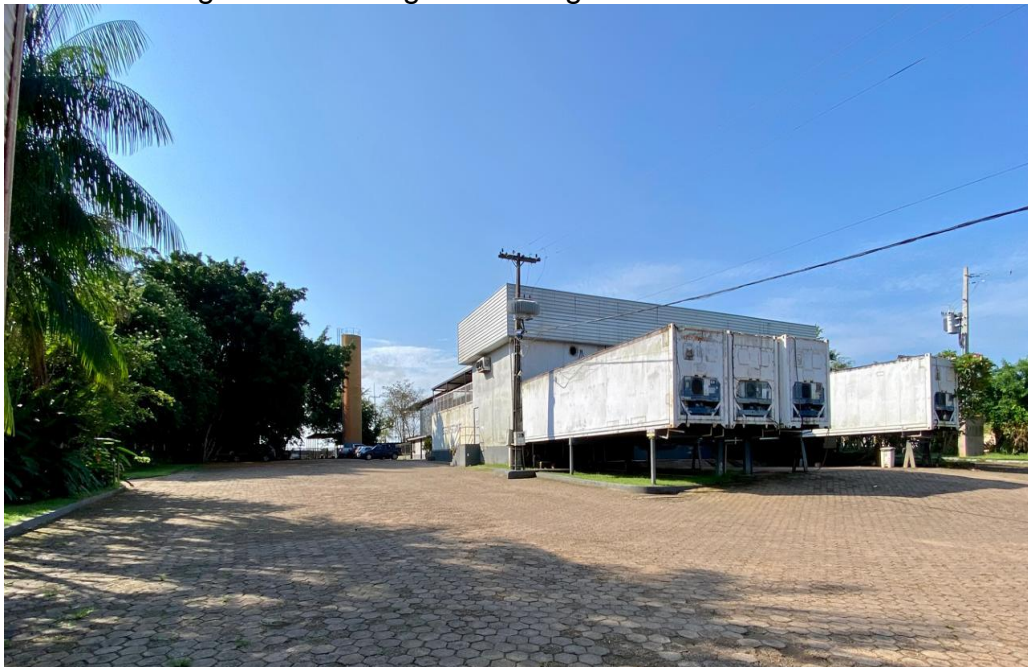
Figura 12. Vista geral do Frigorífico Areia Branca
