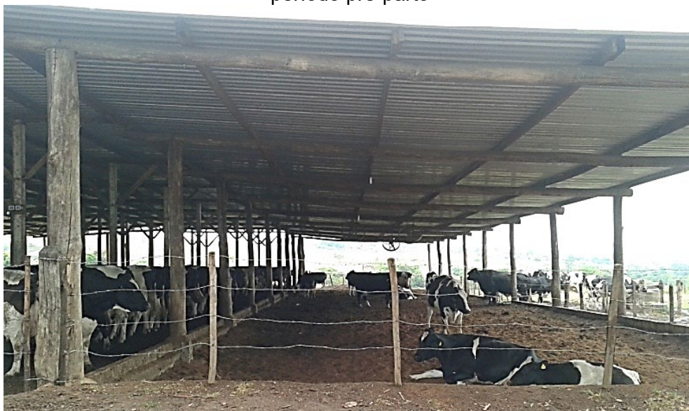
Figura 9: Instalação do tipo Loosinghouse para manutenção dos animais no período pré-parto
