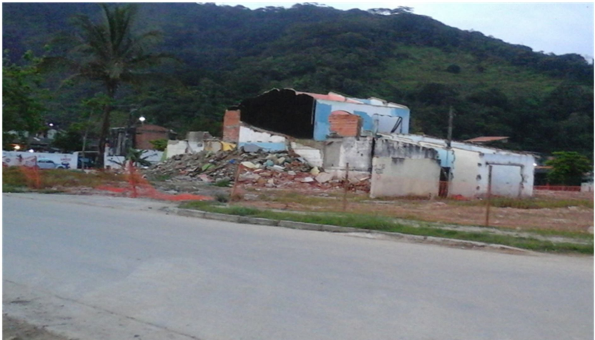
Figura 7: Residências demolidas no bairro do Tinga.
