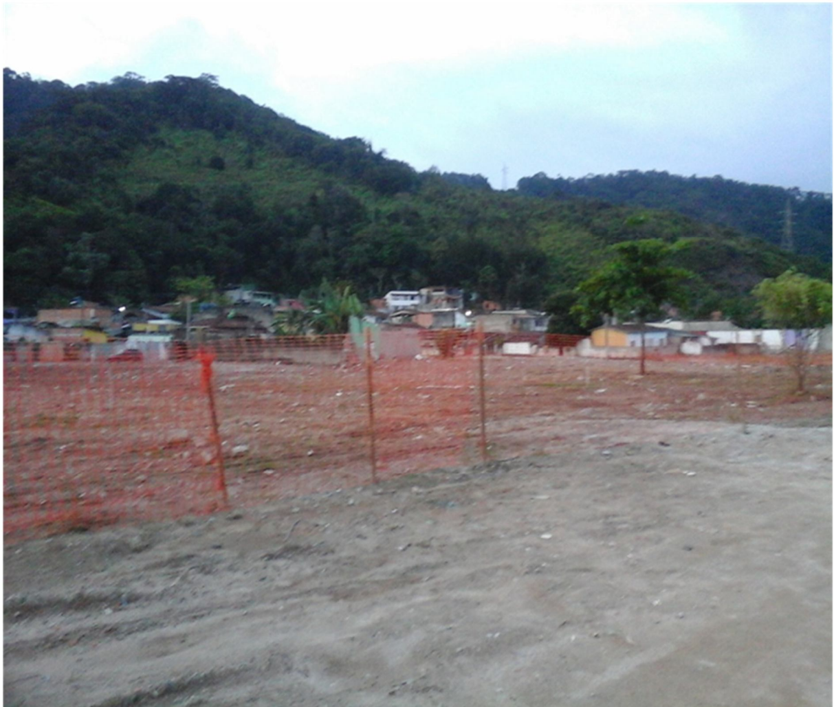
Figura 14: Trecho de demolições no bairro do Tinga.
