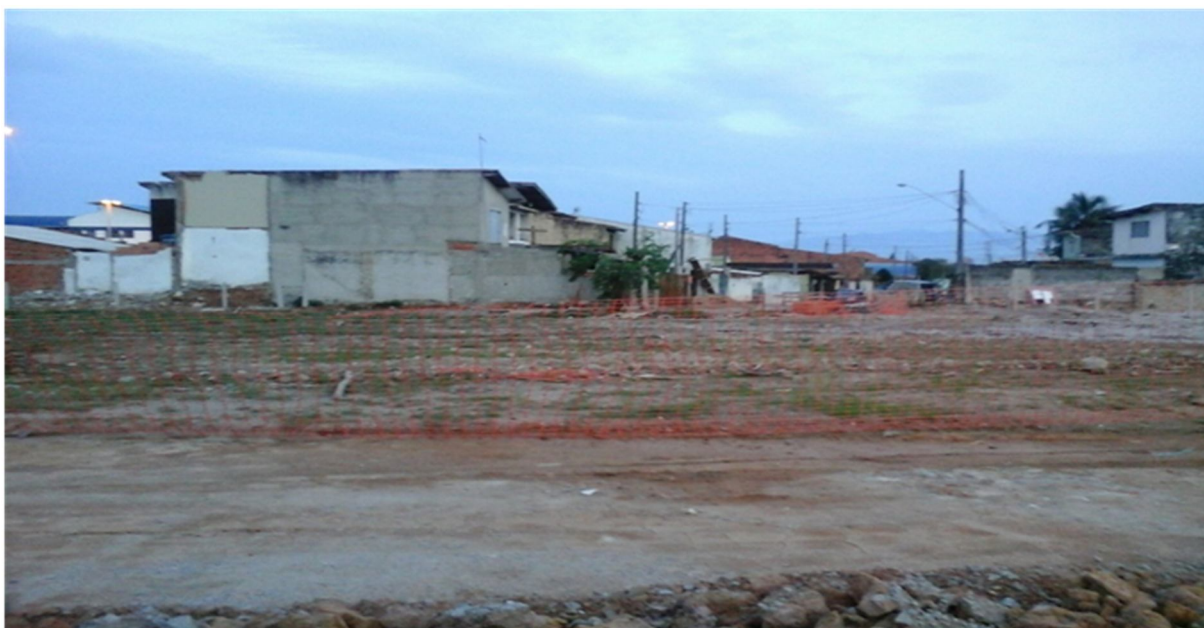
Figura 8: Trecho de demolições no bairro do Tinga.
