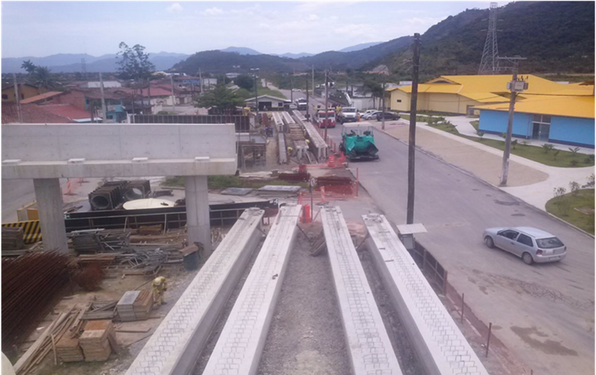
Figura 13: Construção de um viaduto no Jardim Jaqueira.
