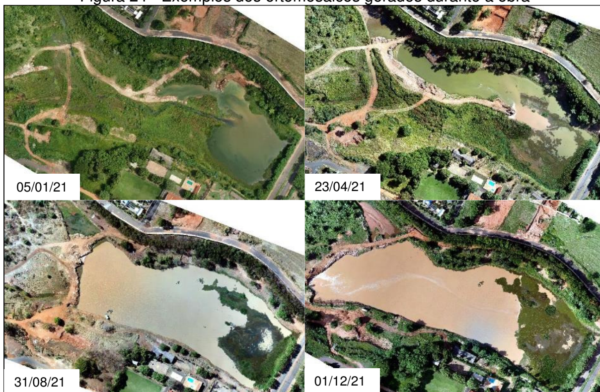
Figura 24 - Exemplos dos ortomosaicos gerados durante a obra
