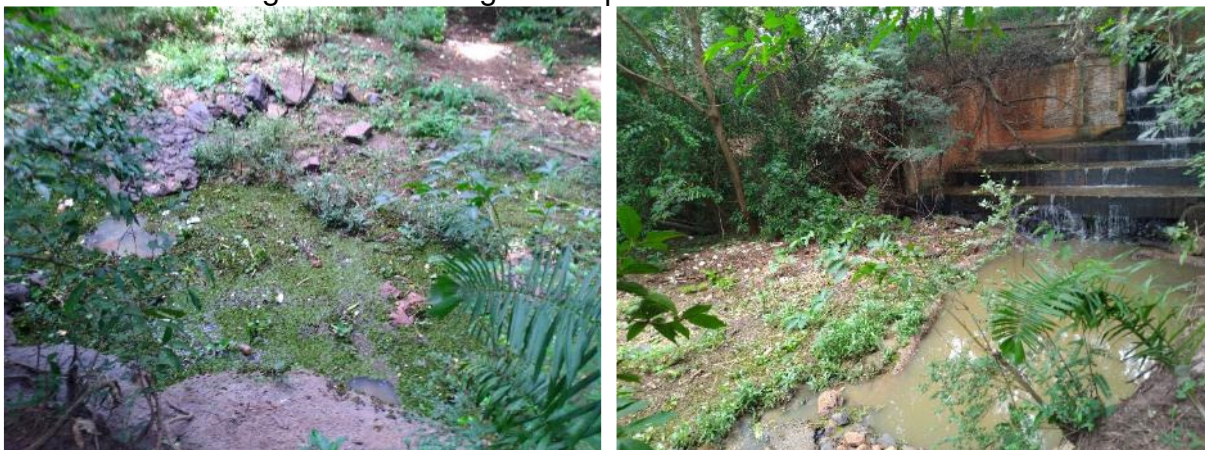
Figura 17 - Vista geral do ponto de monitoramento S
